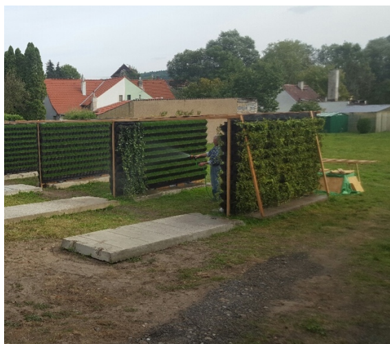
Obr. č. 29: instalace stěnových systémů (zdroj: Němec)
