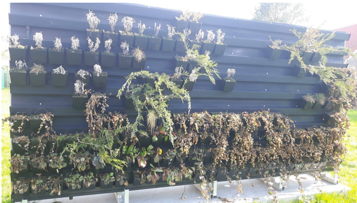
Obr. č. 38: Demontáž stěny B – 9.4. 2017 (zdroj: Brothánek)
