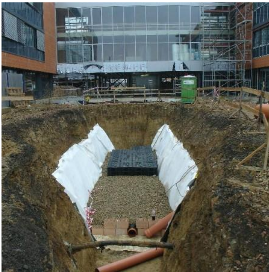
Obrázek 1.9 Ukázka zhotovení retenčního zařízení
