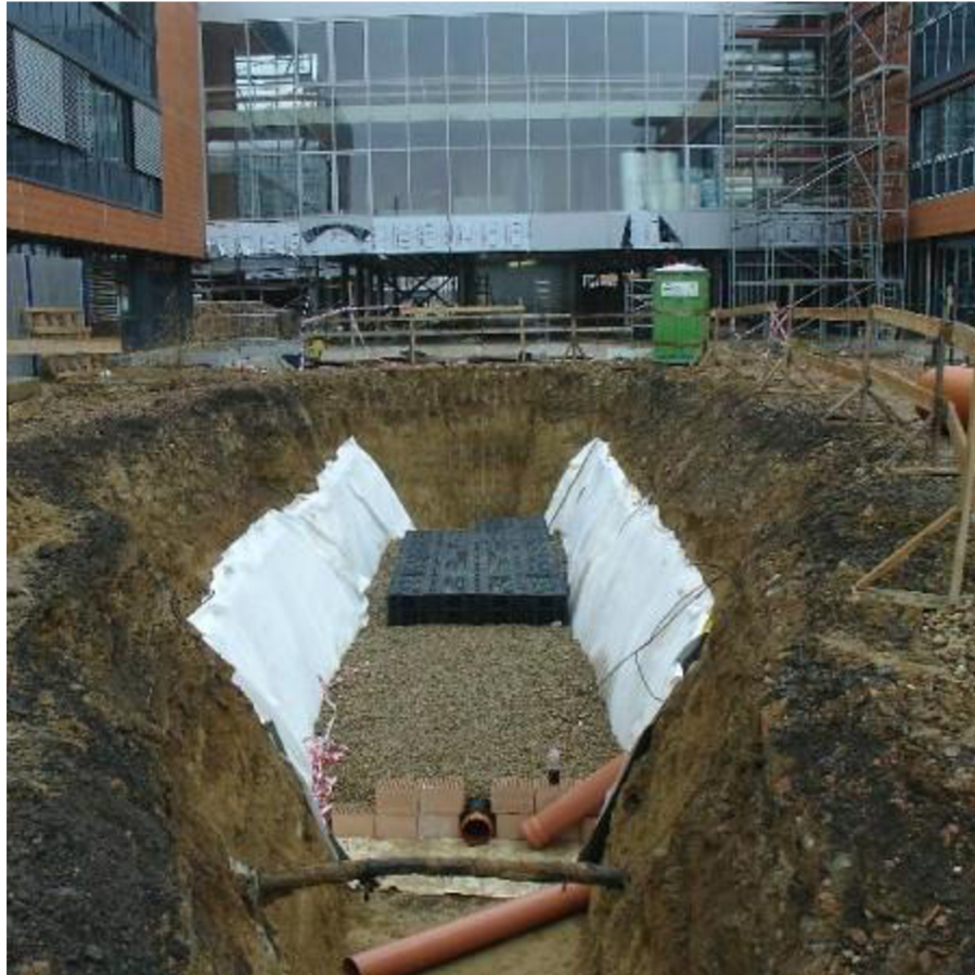
Obrázek 1.9 Ukázka zhotovení retenčního zařízení
