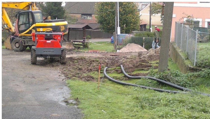
Stavba teplovodu v obci Kladruby (Autor, říjen 2014)
