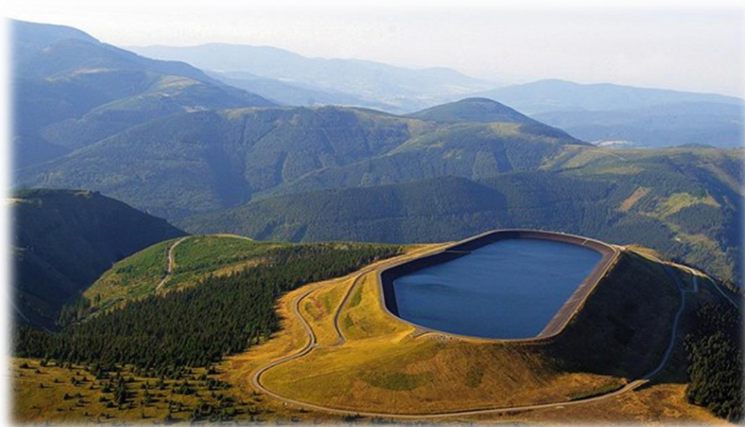
Obr. 3: Přečerpávací vodní elektrárna Dlouhé Stráně (URL 3)
