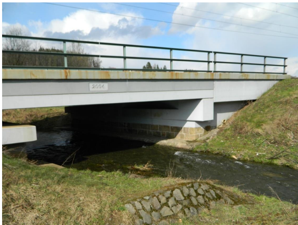
Příloha 21 Železniční most přes potok Nemilka (2004)
