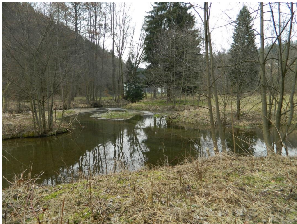
Příloha 19 Odkalovací nádrž
