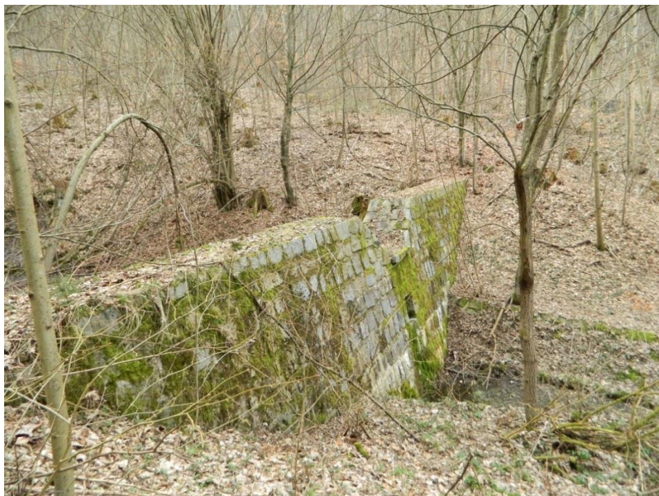
Příloha 18 Terasová hráz u pravobřežní obvodové cesty
