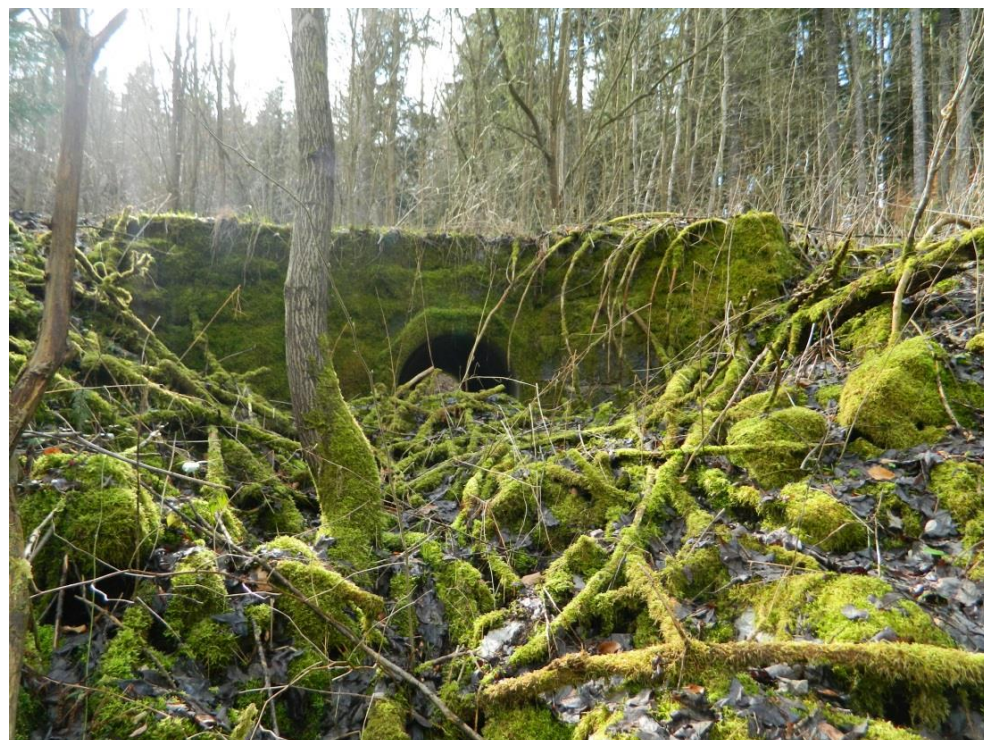
Příloha 17 Propust pod pravobřežní cestou
