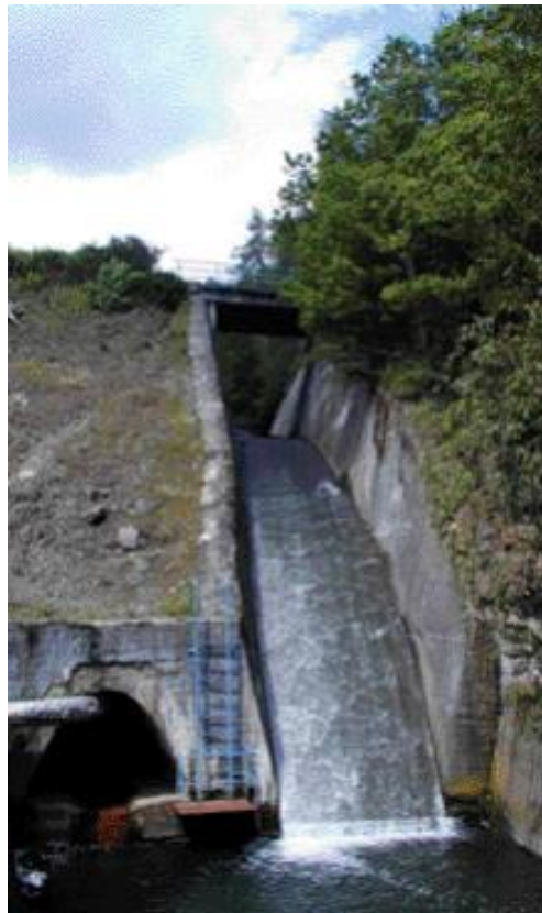
Obr. 5 Přeliv a vstup do odpadní štol. Zdroj: Povodí Odry, 2004
