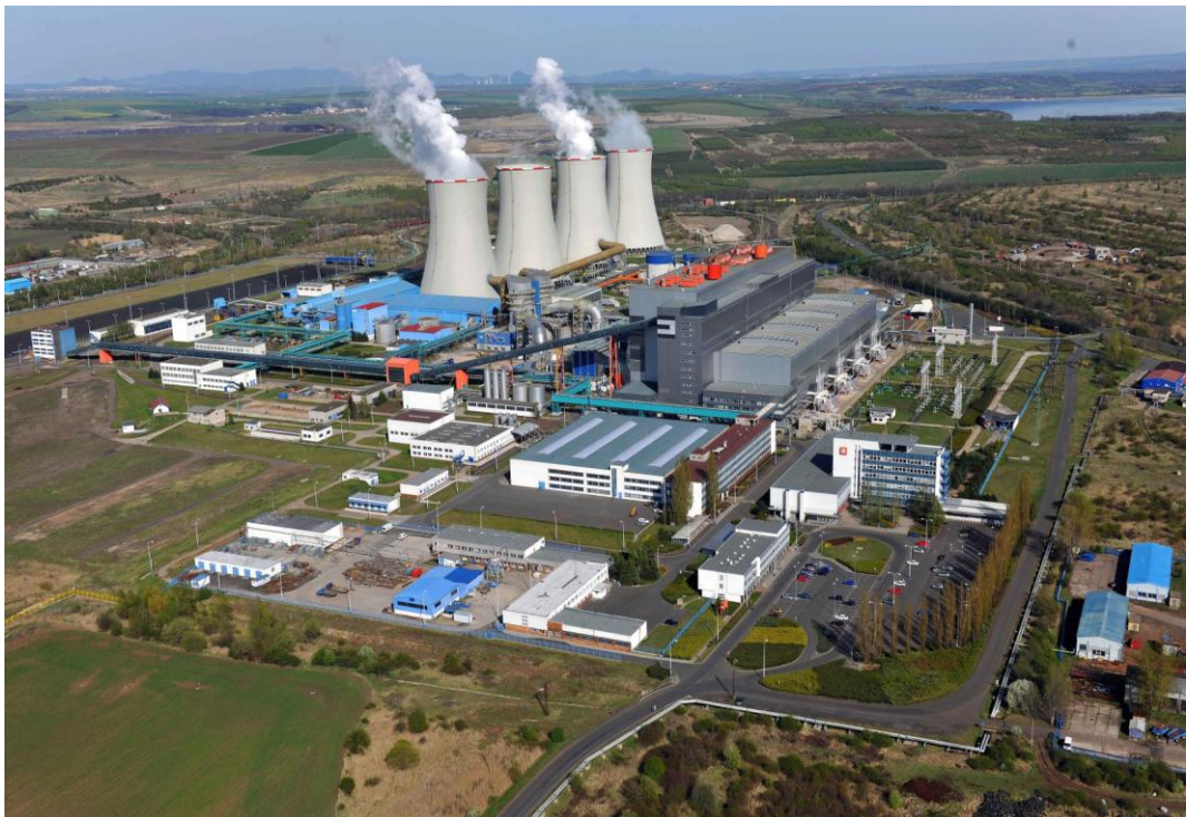
Foto č. 2: Elektrárna po komplexní obnově (ČEZ a. s., 2013)
