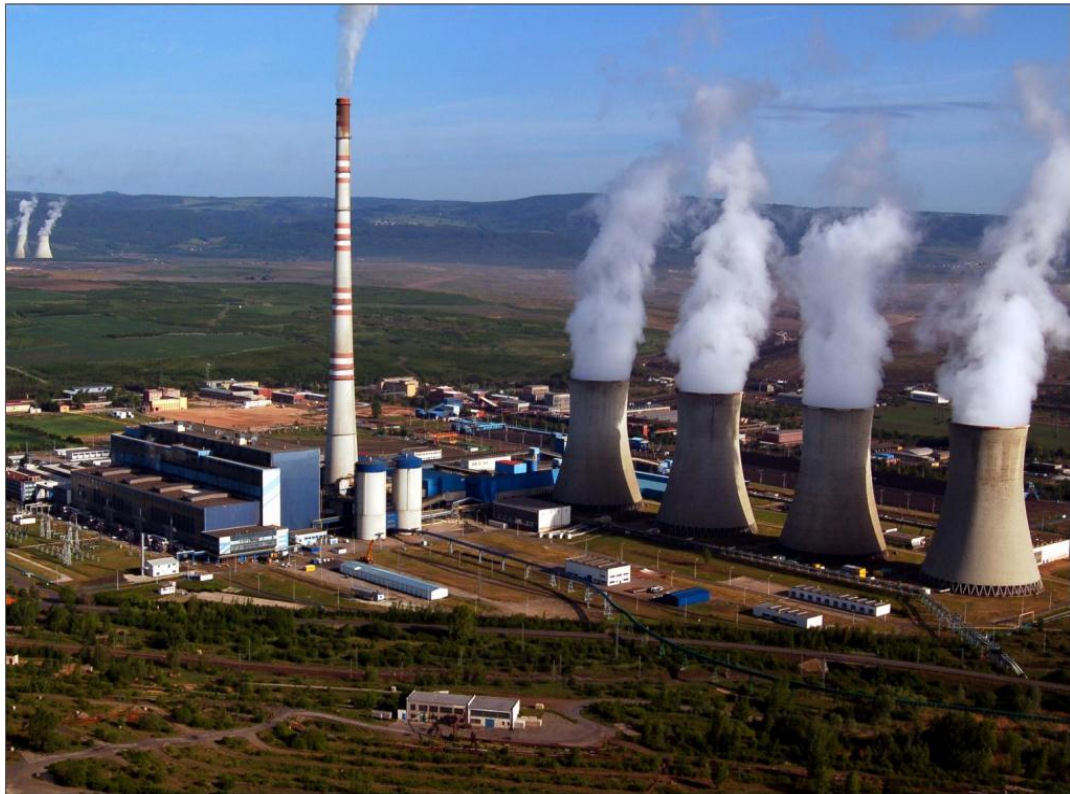
Foto č. 1: Elektrárna před komplexní obnovou (ČEZ a. s., 2013)
