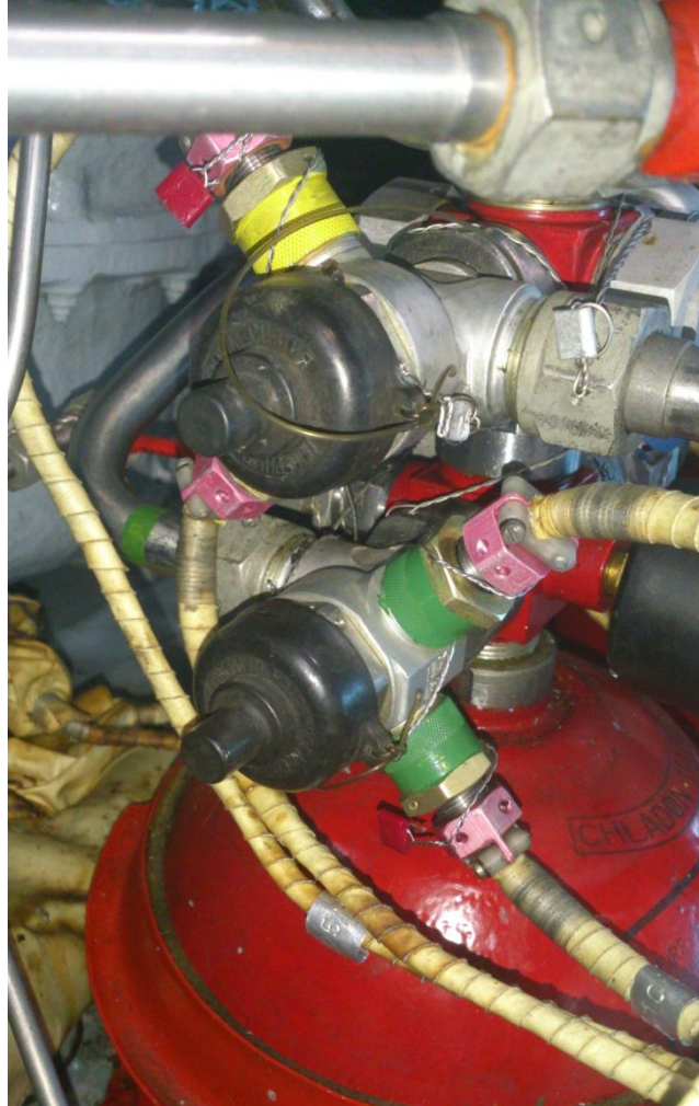
Obrázek 9 Detail pyrotechnického ventilu a pyrohlavice, Zdroj: vlastní, 2017
