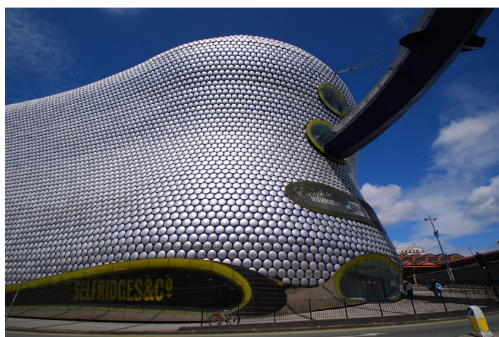
Obr. 43: Selfridges Birmingham ve Velké Británii, architekt Jan Kaplický
