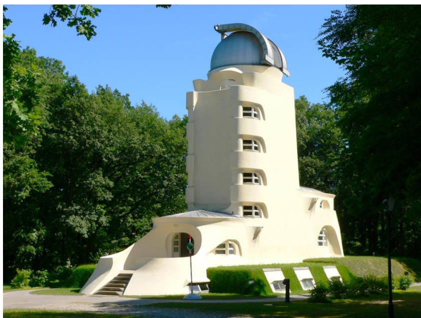
Obr. 25: Einsteinova věž v Postupimi v Německu, architekt Erich Mendelsohn
