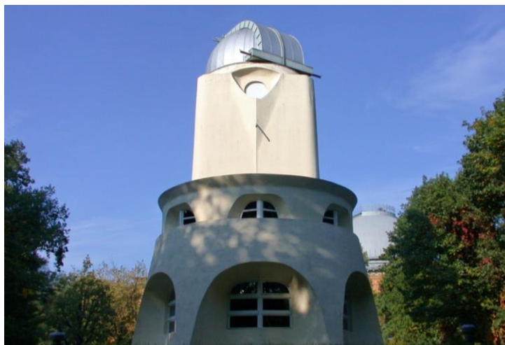
Obr. 26: Einsteinova věž v Postupimi v Německu, architekt Erich Mendelsohn
