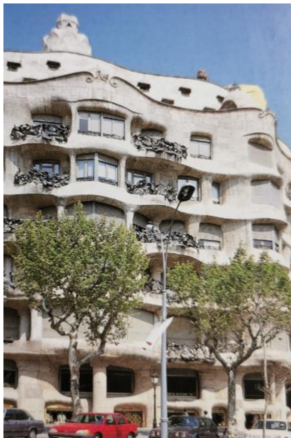
Obr. 16: Casa Milà v Barceloně ve Španělsku, architekt Antoni Gaudí
