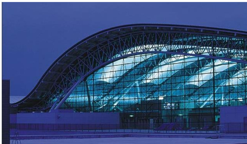
Obr. 35: Mezinárodní letiště Kansai v Osace v Japonsku, architekti Renzo Piano Building Workshop
