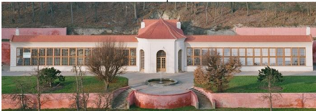
Obrázek 17 Budova Břevnovské oranžerie po rekonstrukci
