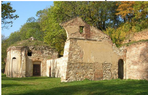
Obrázek 14 Budova oranžerie před rekonstrukcí
