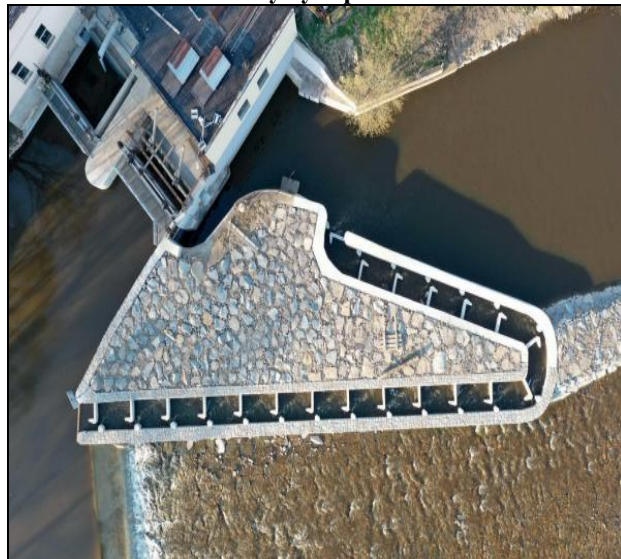
Obrázek 30 - Štěrbínový rybí přechod v Řevnicích
