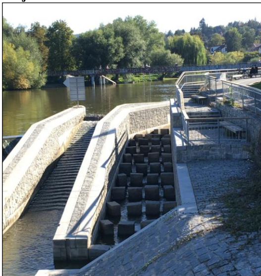
Obrázek 29 - Fotografie rybího přechodu na jezu Černošice
