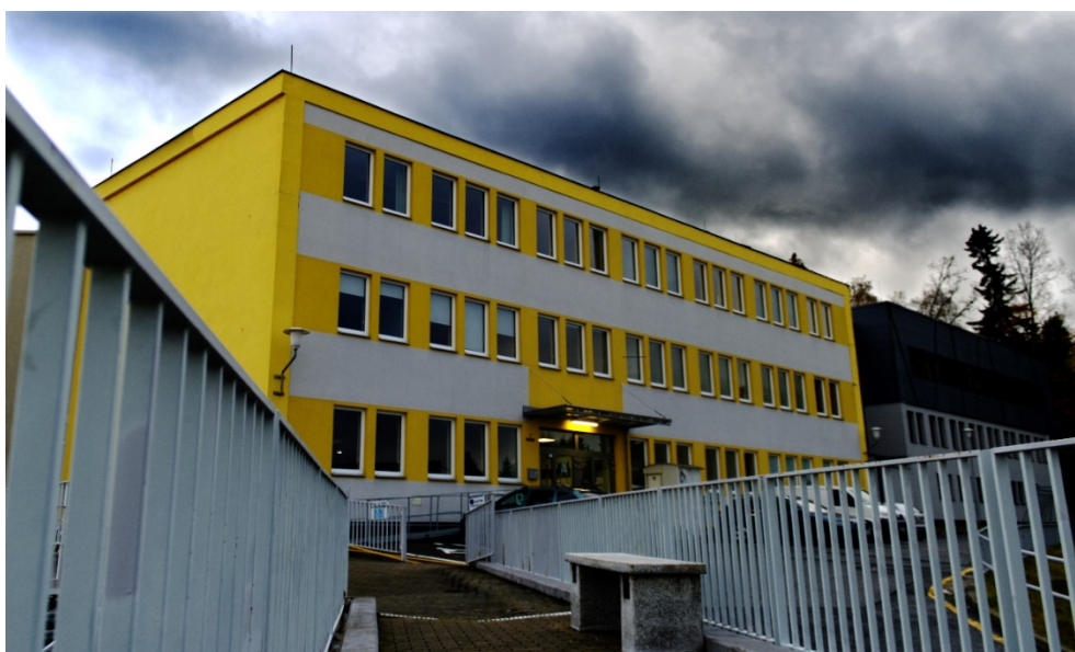
Obrázek 4 Přilehlá vstupní budova atletické haly
