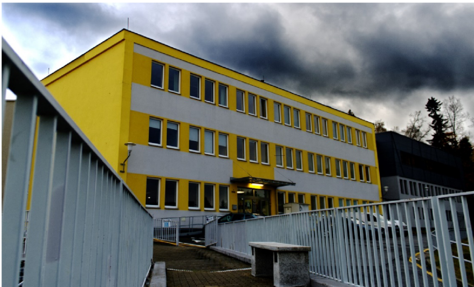
Obrázek 4 Přilehlá vstupní budova atletické haly
