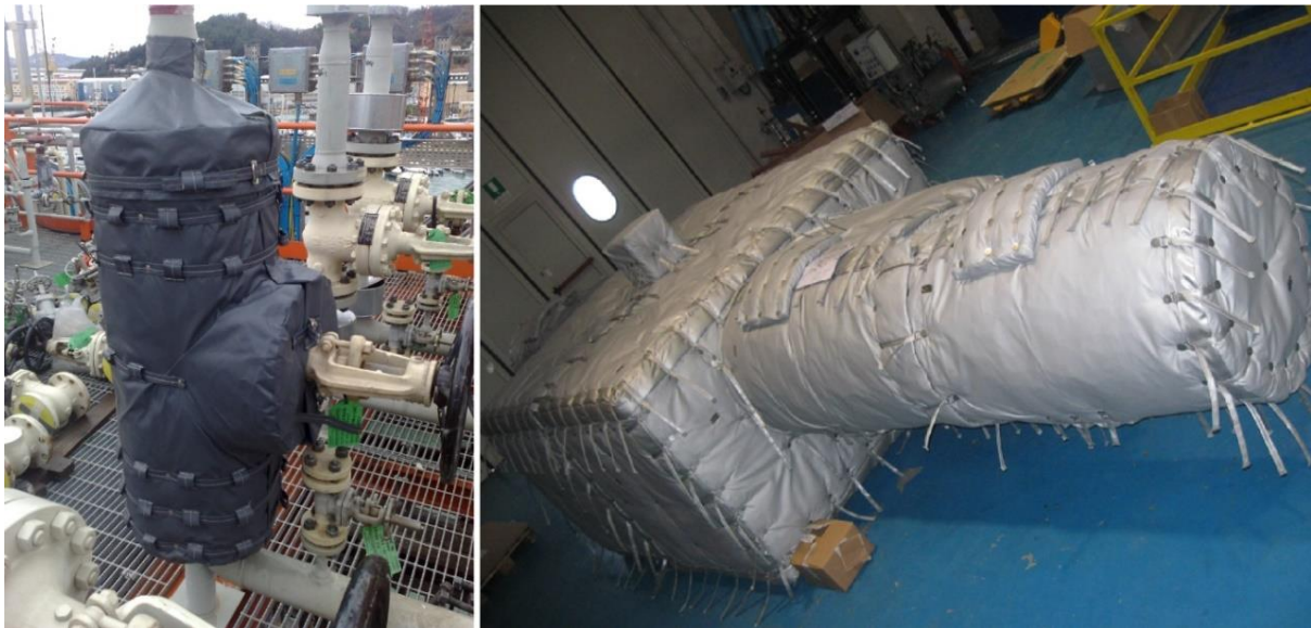
Obr. 6) Pasivní ochrana boxem s keramickými vlákny [16]
