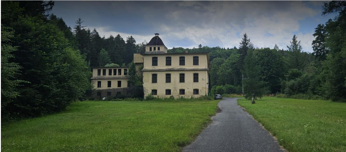
Obrázek 6 Budova paintballové arény Zdroj: vlastní fotografie
