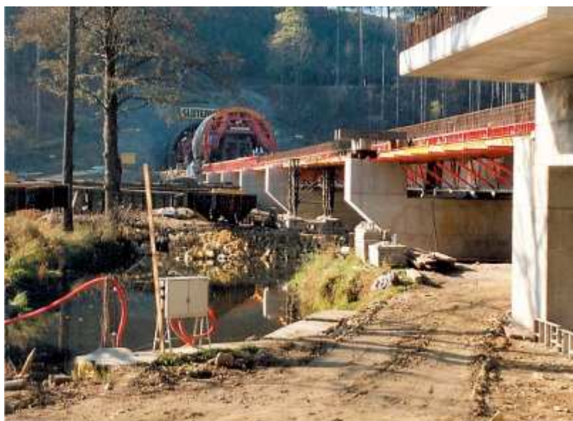
Výstavba železničního mostu a tunelu u Matenic (2003)
