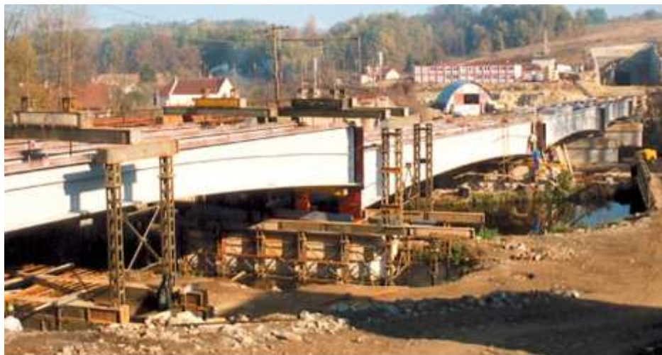
Výstavba železničního mostu u Krasíkova (2003)
