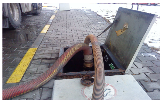
Obr. 16: Napojení stáčecích hadic
