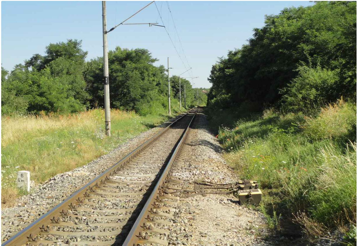
FOTO 5 - POHLED Z KŘÍŽENÍ ULICE KAŠTANOVY A ŽEL. TRATĚ č.300 SMĚREM NA ČERNOVICE
