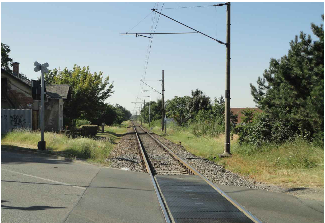
FOTO 4 - POHLED Z KŘÍŽENÍ ULICE KAŠTANOVY A ŽEL. TRATĚ Č.300 SMĚREM NA CHRLLICE
