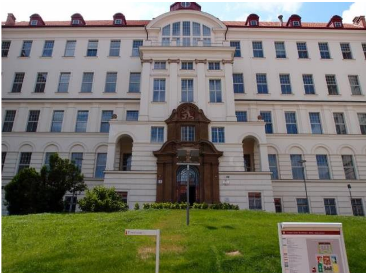
Obr. 4.1 Budova Z fakulty stavební VUT v Brně na ulici Žižkova [6]
