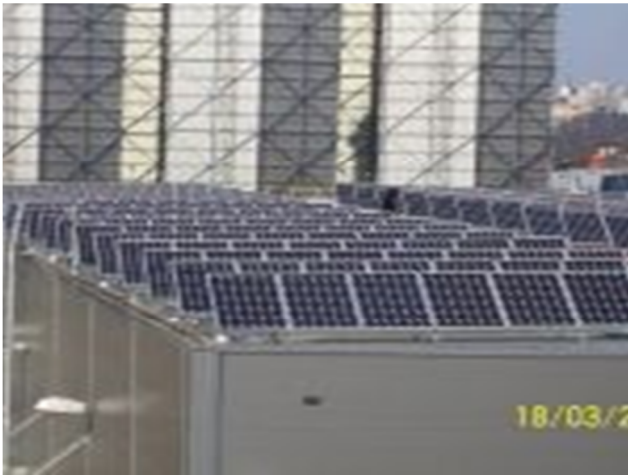
Obrázek č. 18 Instalace elektrárny na střeše Škodovky
