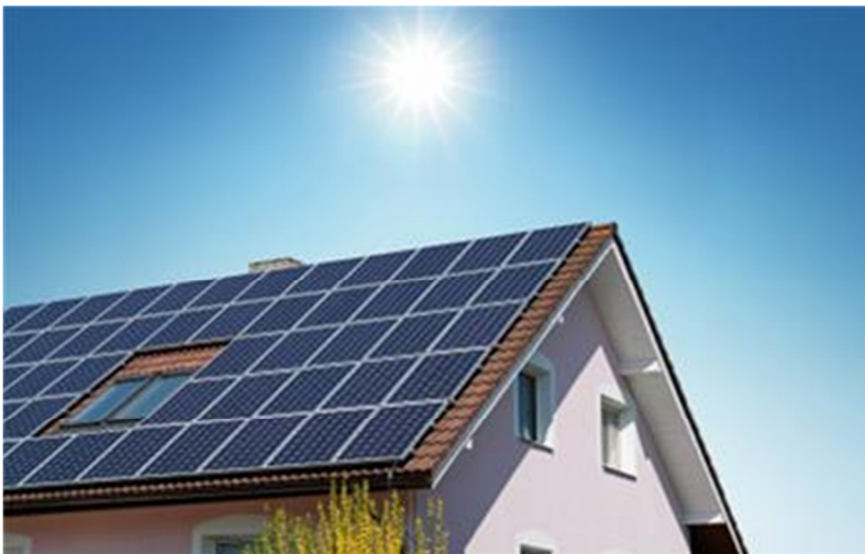
Obrázek č. 19 Instalace elektrárny na střeše rodinného domu
