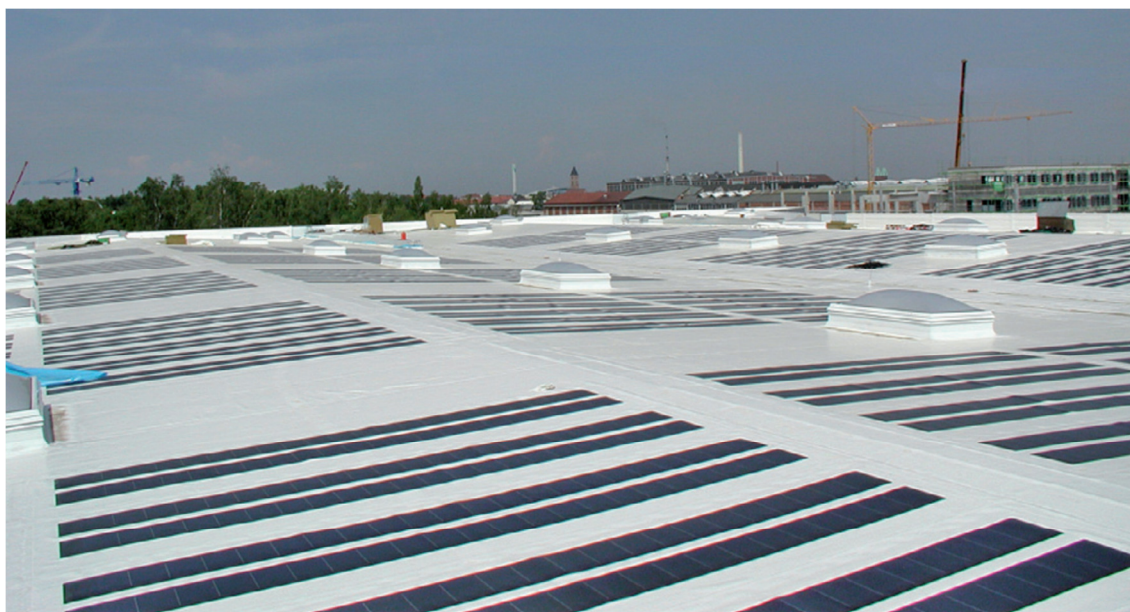
Obrázek č. 12 Integrovaný fotovoltaický systém pro ploché střechy
