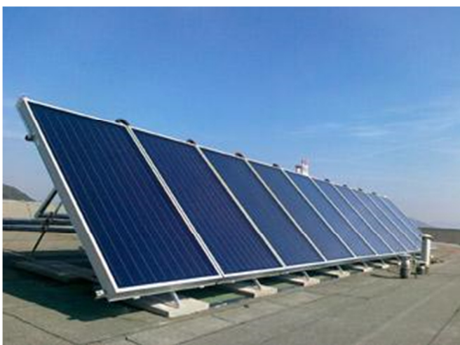
Obrázek č. 17 Instalace panelů na střeše
