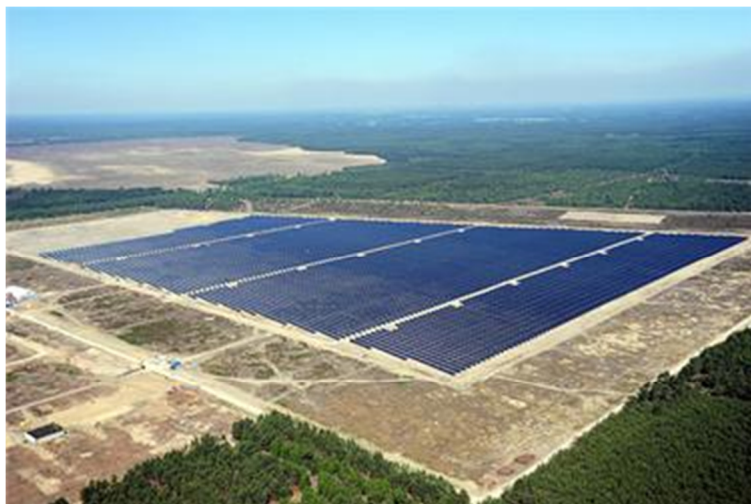
Obrázek č. 15 Fotovoltaická elektrárna Lieberose v Německu
