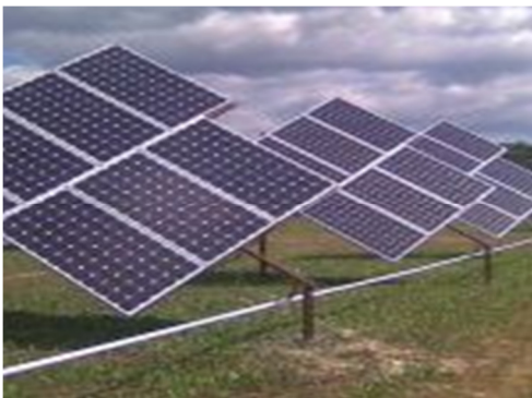
Obrázek č. 20 Instalace jednoosé otočné elektrárny
