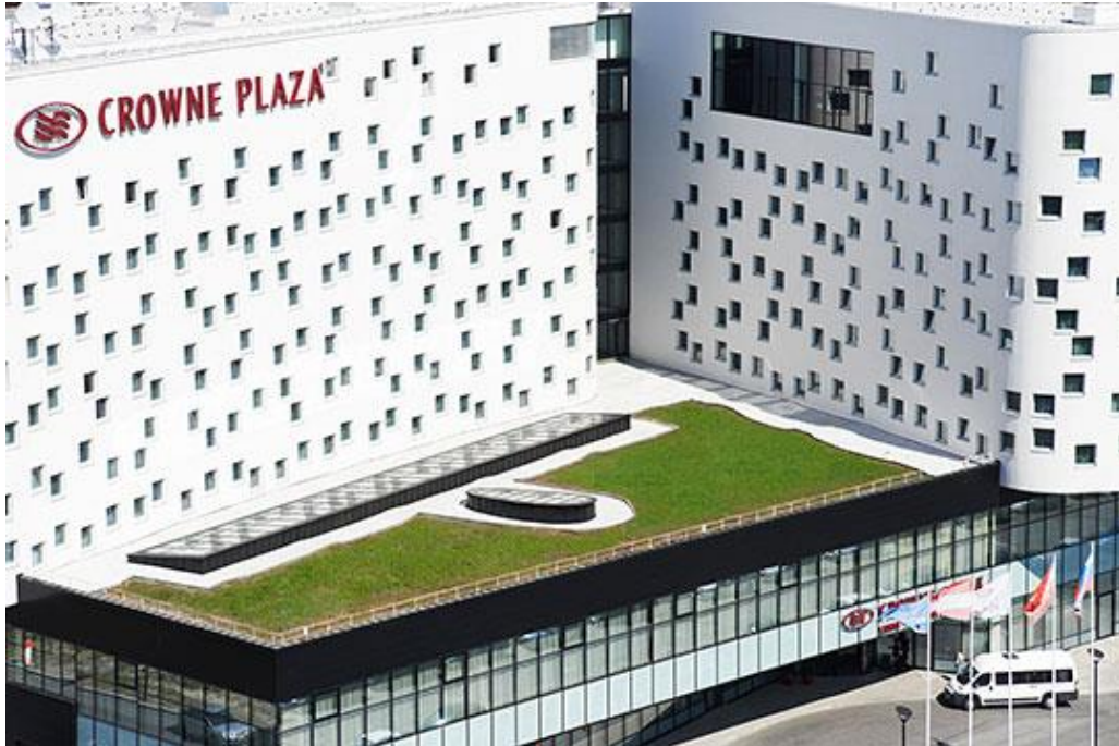
Obrázek 7 Střecha obchodního centra Crowne Plaza v Petrohradě o celkové rozloze více než 2000 m 2 [13]
