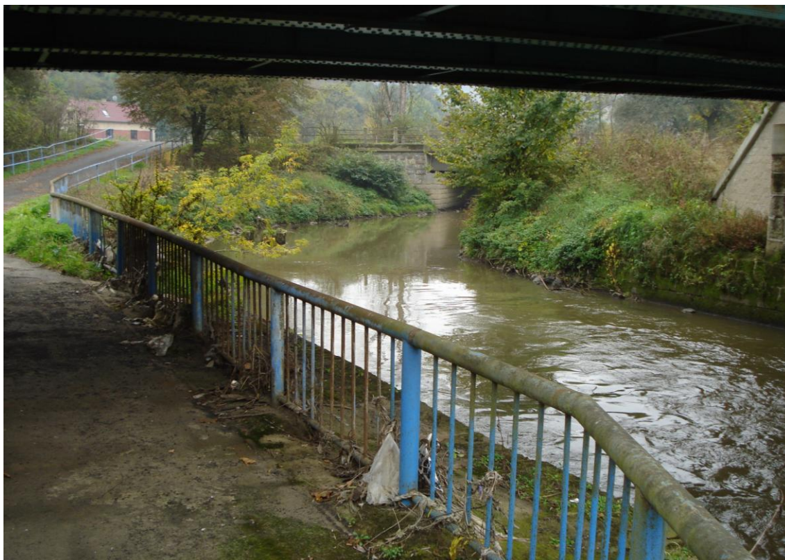
Obr. č. 18 Skládka č.2 (zdroj: vlastní)
