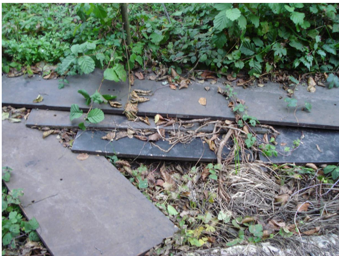
Obr. č. 23 Skládka č.7 (zdroj: vlastní)
