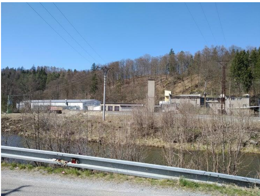
Areál bývalé Schenkovy továrny (objekt č. p. 90) v Raškově (foto: Jakub Morong 4. 4. 2020)
