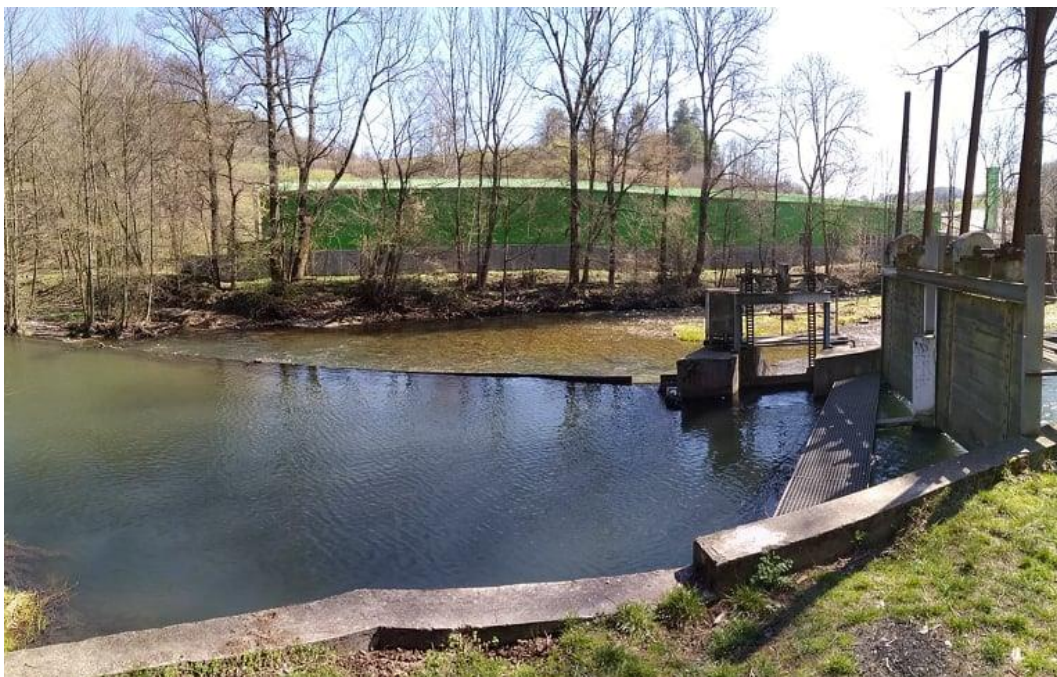
Jez (315 ř. km) a stavidla s náhonem k MVE Ruda nad Moravou (foto: Jakub Morong 4. 4. 2020)
