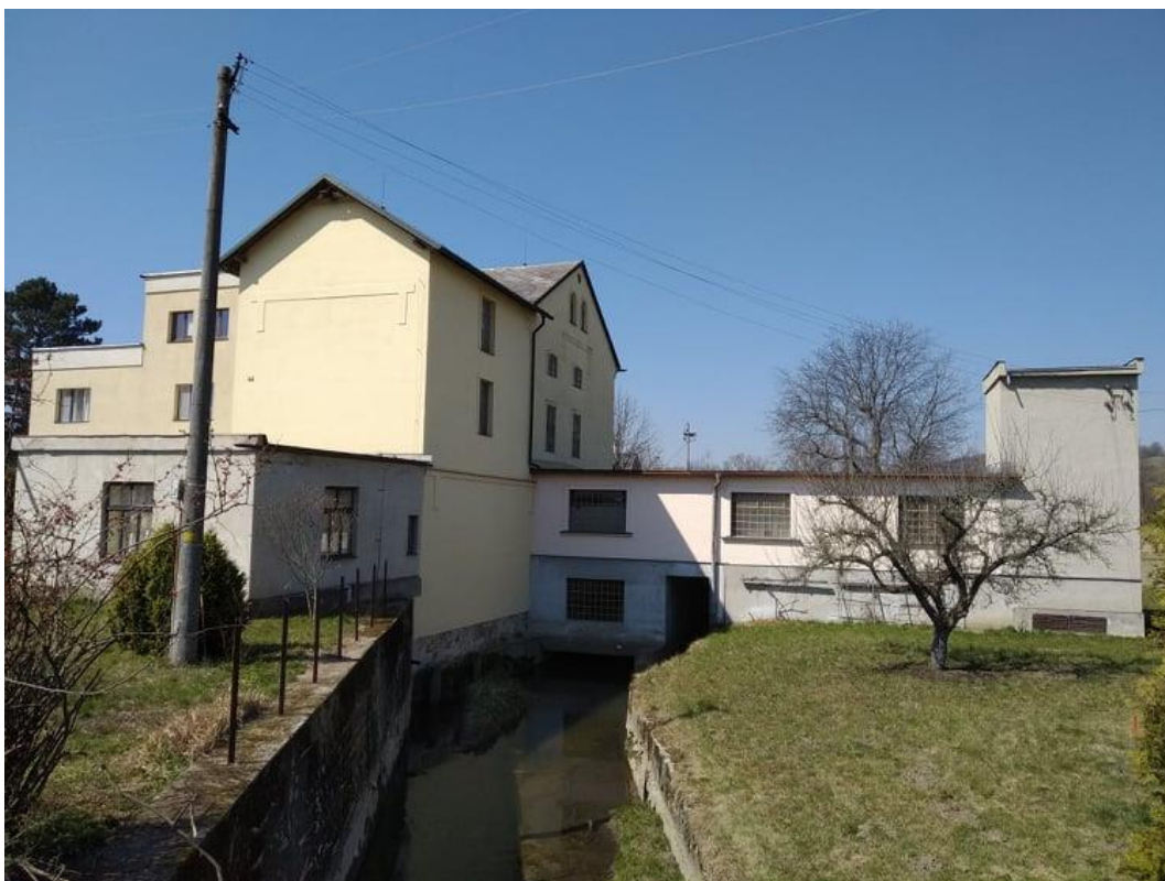
Strojovna turbíny (mlýnské) v budově bývalého mlýna (objekt č. p. 64) v Chromči (foto: Jakub Morong 5. 4. 2020)
