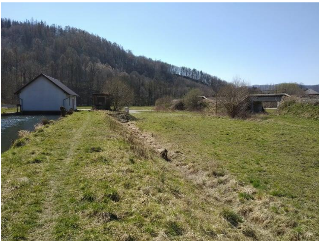
MVE Ruda nad Moravou a propustka zaniklého náhonu v drážním tělese (foto: Jakub Morong 4. 4. 2020)
