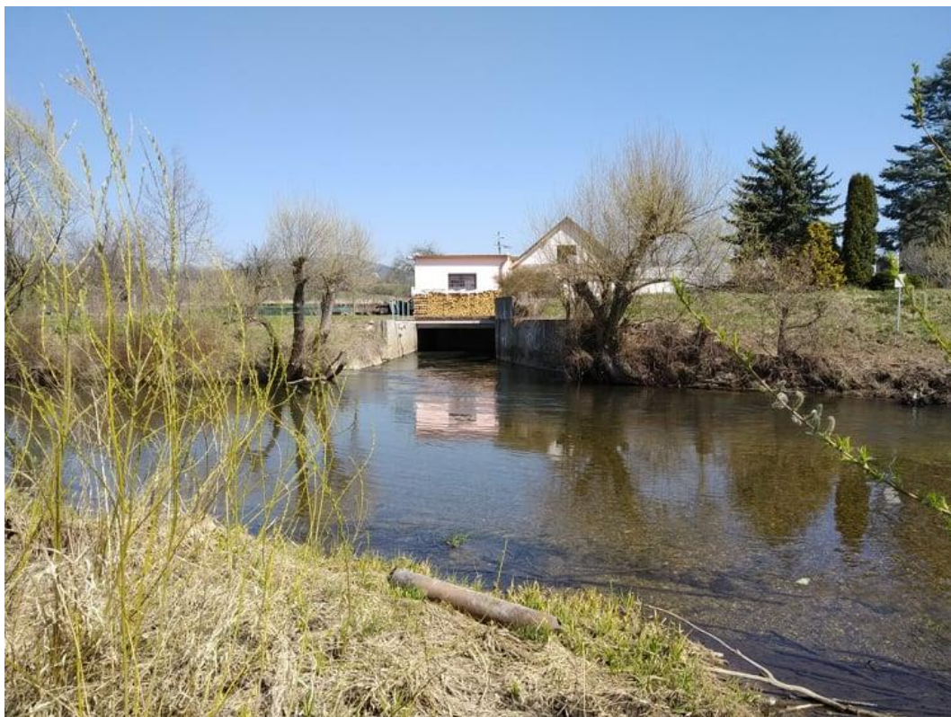
Strojovna turbíny (elektrárenské) v areálu bývalého mlýna v Chromči (foto: Jakub Morong 5. 4. 2020)
