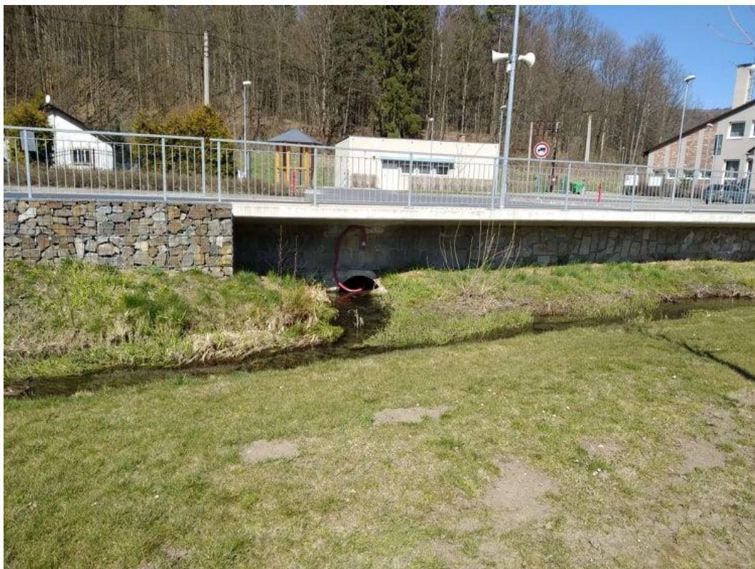
Místo zaniklé pily a mlýna (objekt č. p. 66) v Raškově (foto: Jakub Morong 4. 4. 2020)
