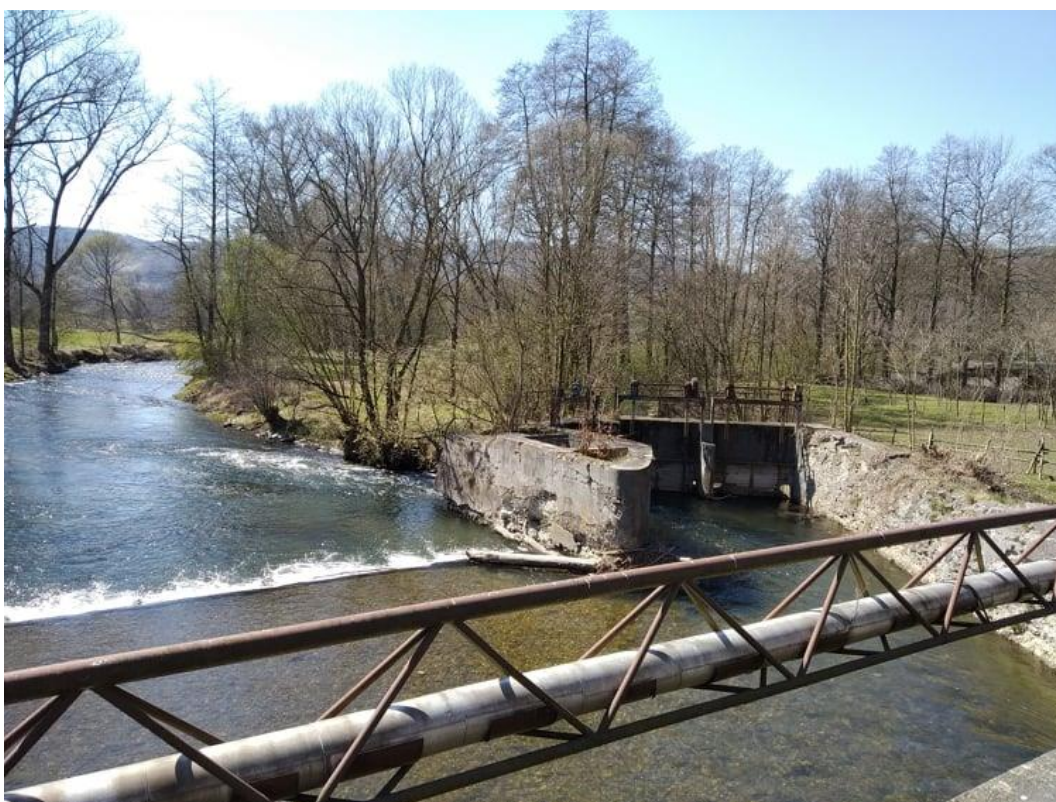
Jez v Bartoňově (313,3 ř. km) a stavidla náhonu vedoucího k Olšanské papírně
