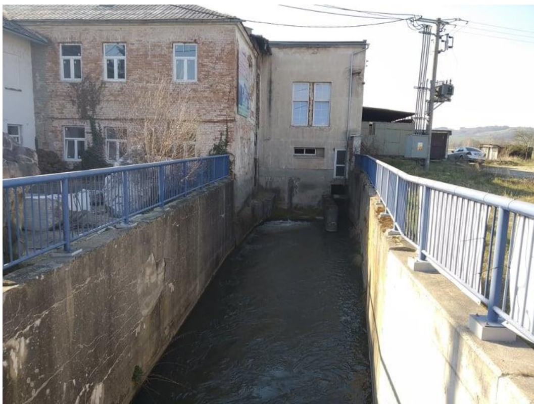
Strojovna MVE v objektu bývalého mlýna (objekt č. p. 81) v Bludově (foto: Jakub Morong 5. 4. 2020)
