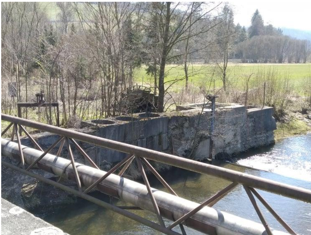
Staré mlýnské kolo na jezu v Bartoňově; v levé dolní části propustka se zasypaným ústím náhonu (foto: Jakub Morong 4. 4. 2020)
