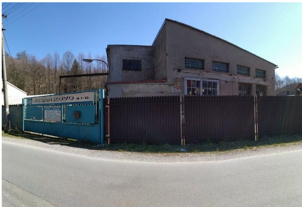
Budova bývalé strojírny a pily (objekt č. p. 158) v Bohdíkově (foto: Jakub Morong 4. 4. 2020)
