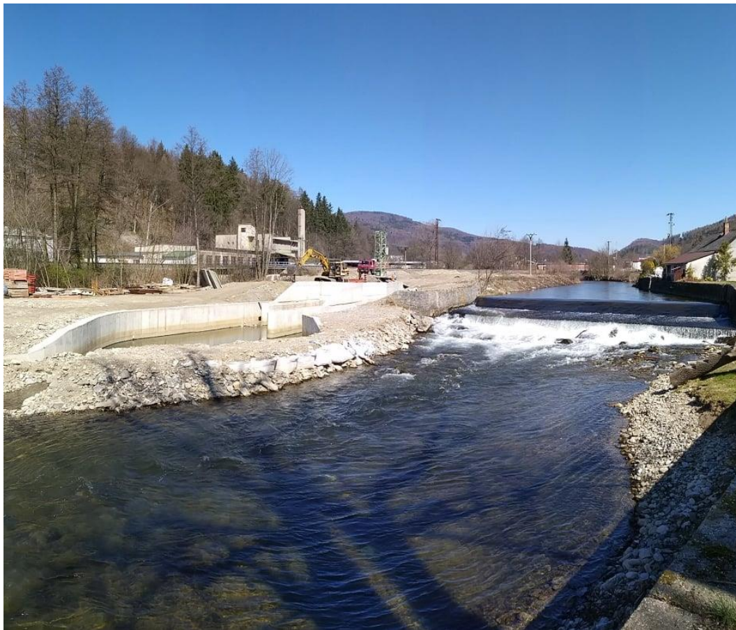
Jez (320,5 ř. km) a stavba MVE v Bohdíkově (foto: Jakub Morong 4. 4. 2020)
