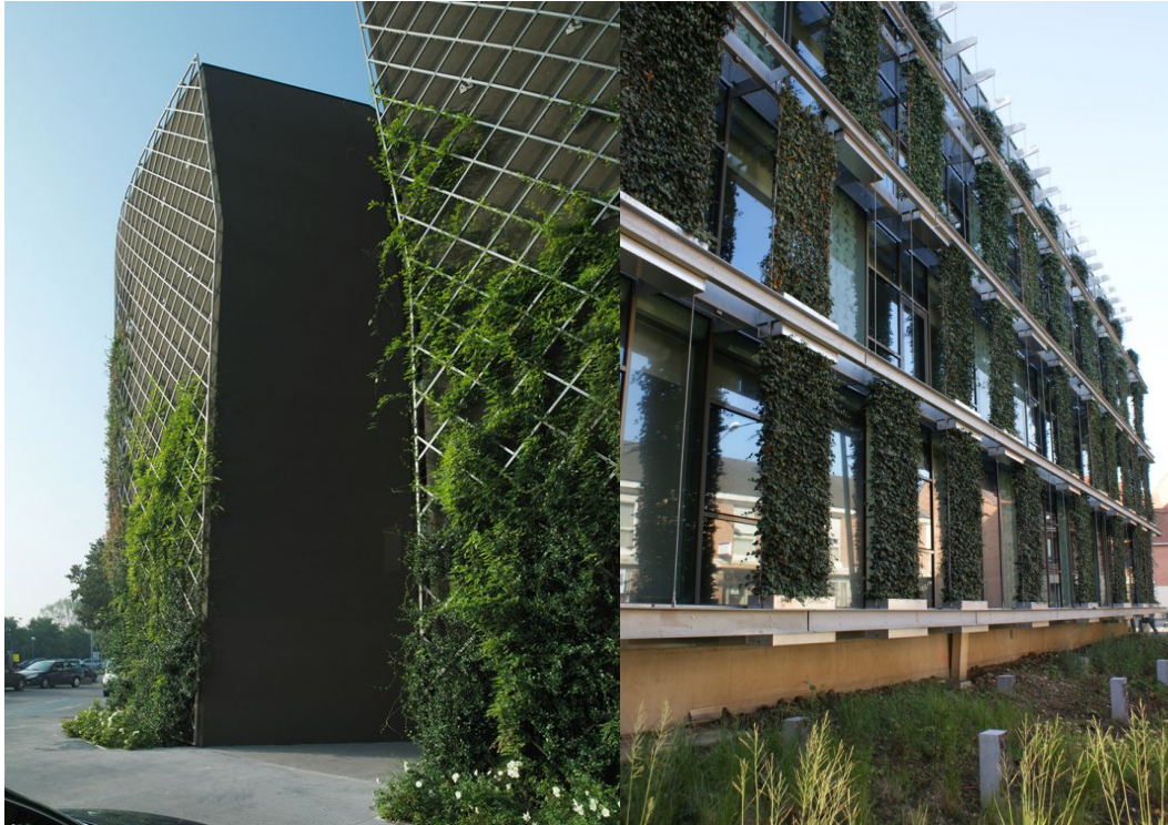
Obrázek 4.26 Mřížový podpůrný systém (vlevo) [62] Modulový systém (vpravo) [63]
