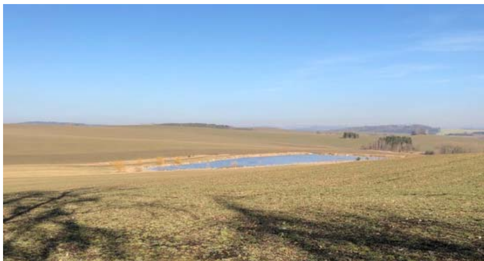
Obrázek 17: Pohled na vodní dílo od jihozápadu
