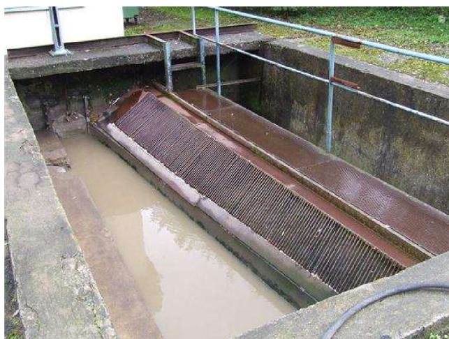
Obrázek 11 Odlehčovací komora (cit. Online [15])
