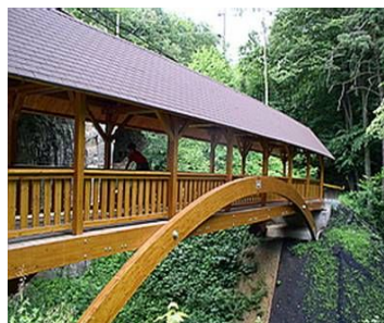
Obr.12 Krytí dřevěného mostu (17)
