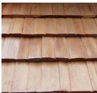
Obr.9-Valašský dřevěný šindel (16)
