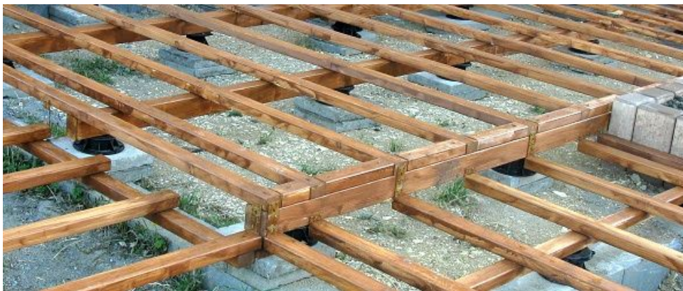
Obr.46- Konstrukce nosného rámu (2)
