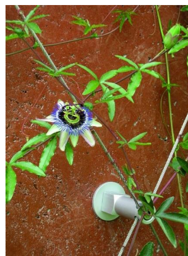
Obr. 2-36: Lankový systém – detail [17]
