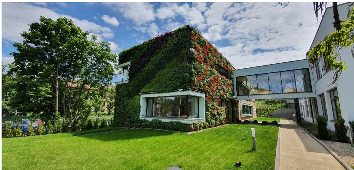
Obr. 5-34: Přístavba kanceláří k objektu KVOP, Brno
