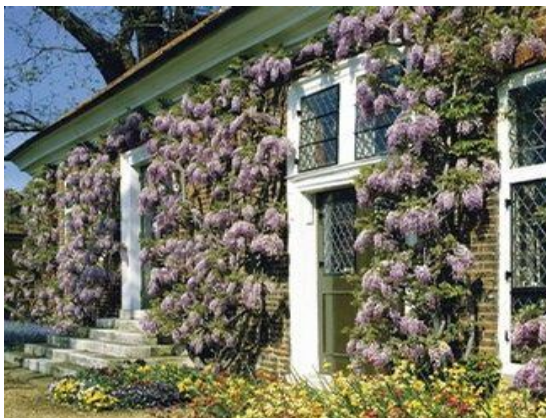
Obr. 2-37: Fasáda objektu porostlá vistárií na treláži
