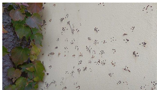
Obr. 2-25: Suché terčičky na fasádě po odtržení
