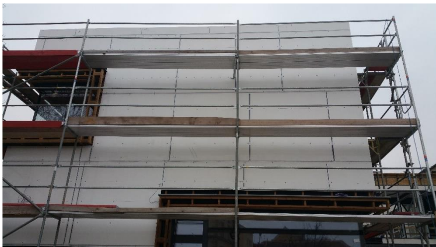
Obr. 5-46: Listopad 2018 - montáž PP desek na hliníkový rošt a přelepení spojů
