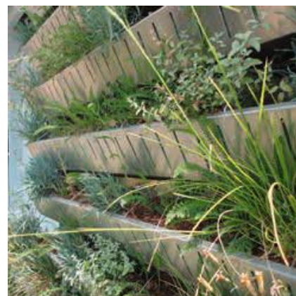
Obr. 2-79: Detail žlabového systému na budově MA 48 [27]
