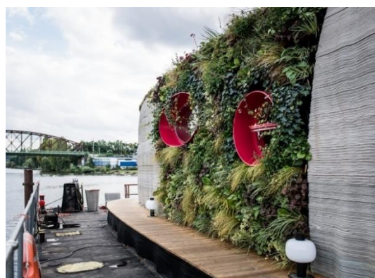
Obr. 2-100: Intenzivní zelená fasáda prvního 3D tištěného domu Prvok v České republice, 2020 [31]
