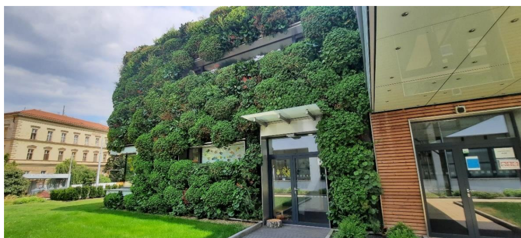
Obr. 5-67: Červenec 2021- západní fasáda
