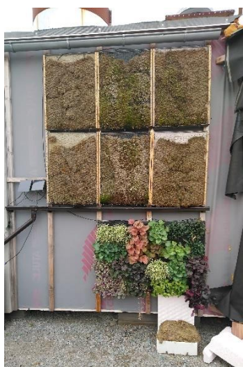
Obr. 5-20: Instalace panelů do svislé polohy
