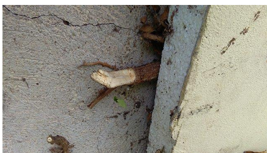
Obr. 2-18: Zarůstání kořenů pod zatepl. systém [13]
