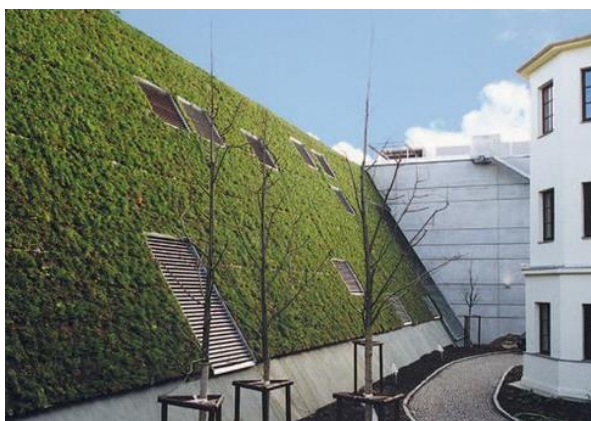
Obr. 2-90: Strmá střecha centra Nový Smíchov, Praha [29]
