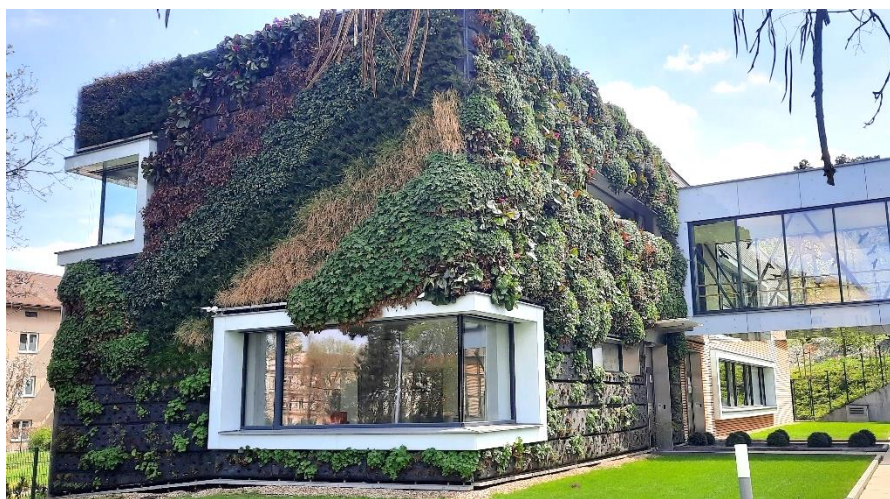
Obr. 5-64: Duben 2021 – vymrznutí spodní části zelené fasády
