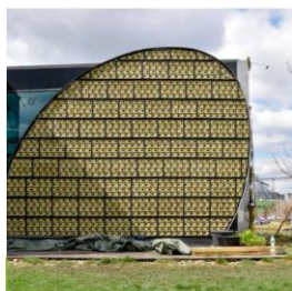
Obr. 2-74: Skládání modulů dle tvaru fasády [25]
