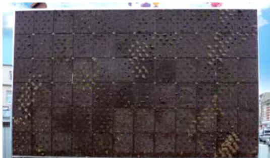
Obr. 2-68: Duben – čerstvě osázená fasáda
