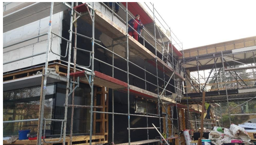
Obr. 5-47: Listopad 2018 - Provedení první vrstvy geotextilie
