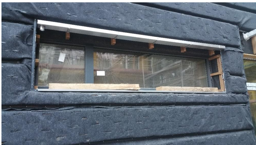
Obr. 5-48: Prosinec 2018 - Uchycení růstového média a druhá vrstva geotextilie
