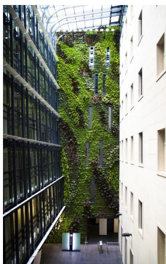
Obr. 2-98: Kancelářská budova Jindřišská, Praha (5000 živých rostlin), (2014) [31]
