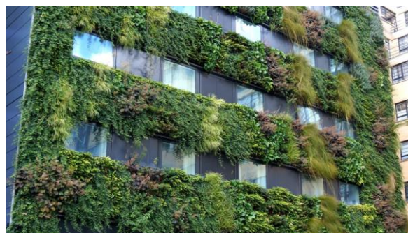
Obr. 2-73: Exteriérová živá stěna bytového domupomocí modulů BioTile, Velká Británie, 2018 [25]
