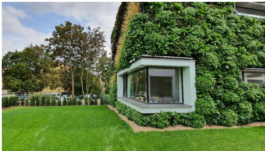
Obr. 5-58: 10/9/2019. – Detail rohového okna
