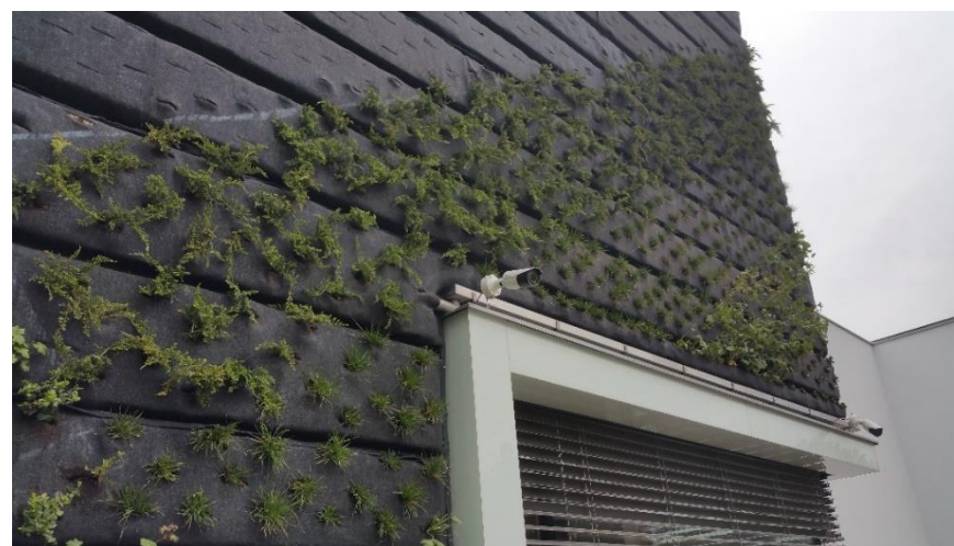
Obr. 5-53: 15/5/2019 - Detail osázení severní fasády
