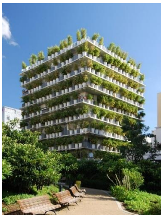
Obr. 2-57: Pohled ze severovýchodní strany [22]
