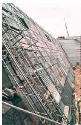
Obr. 2-91: Stav před realizací zelené fasády
