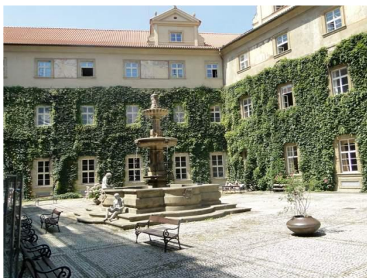
Obr. 2-28: Révové nádvoří po rekonstrukci (2016) [15]
