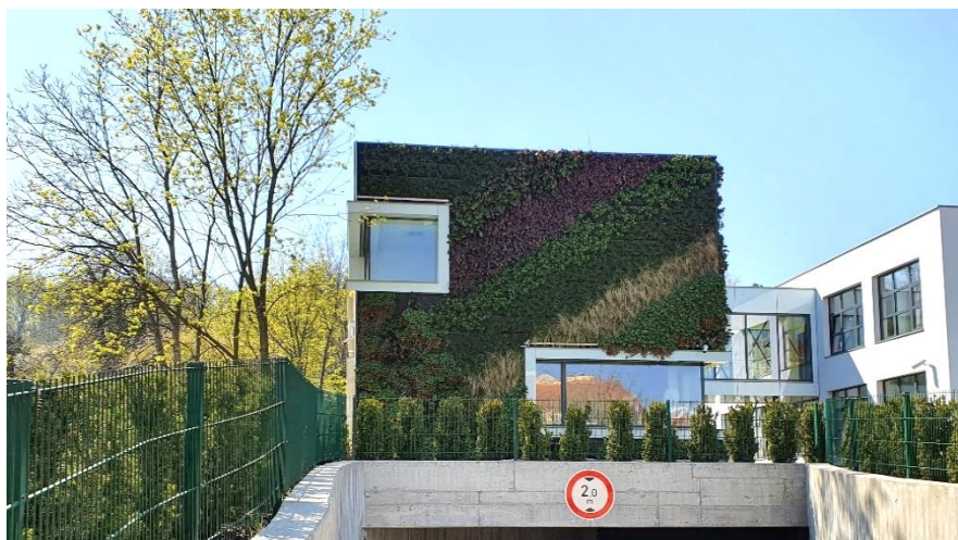
Obr. 5-60: Duben 2020 – severní fasáda
