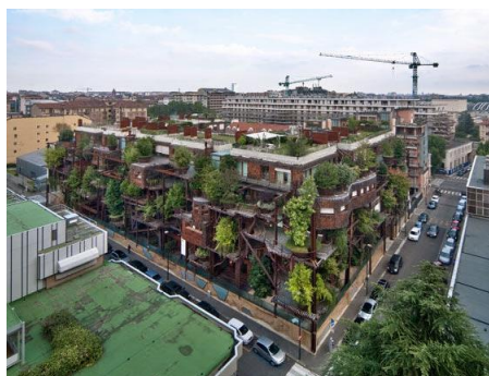
Obr. 2-54: Bytový dům v Turíně, Itálie (2014)
