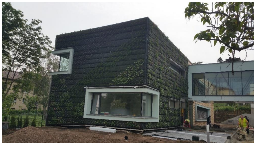
Obr. 5-54: 27/5/2019 - Plně osázená fasáda
