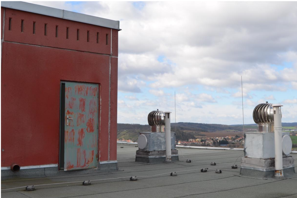
Foto 3 Zakončení šachtového větrání nad střechou
