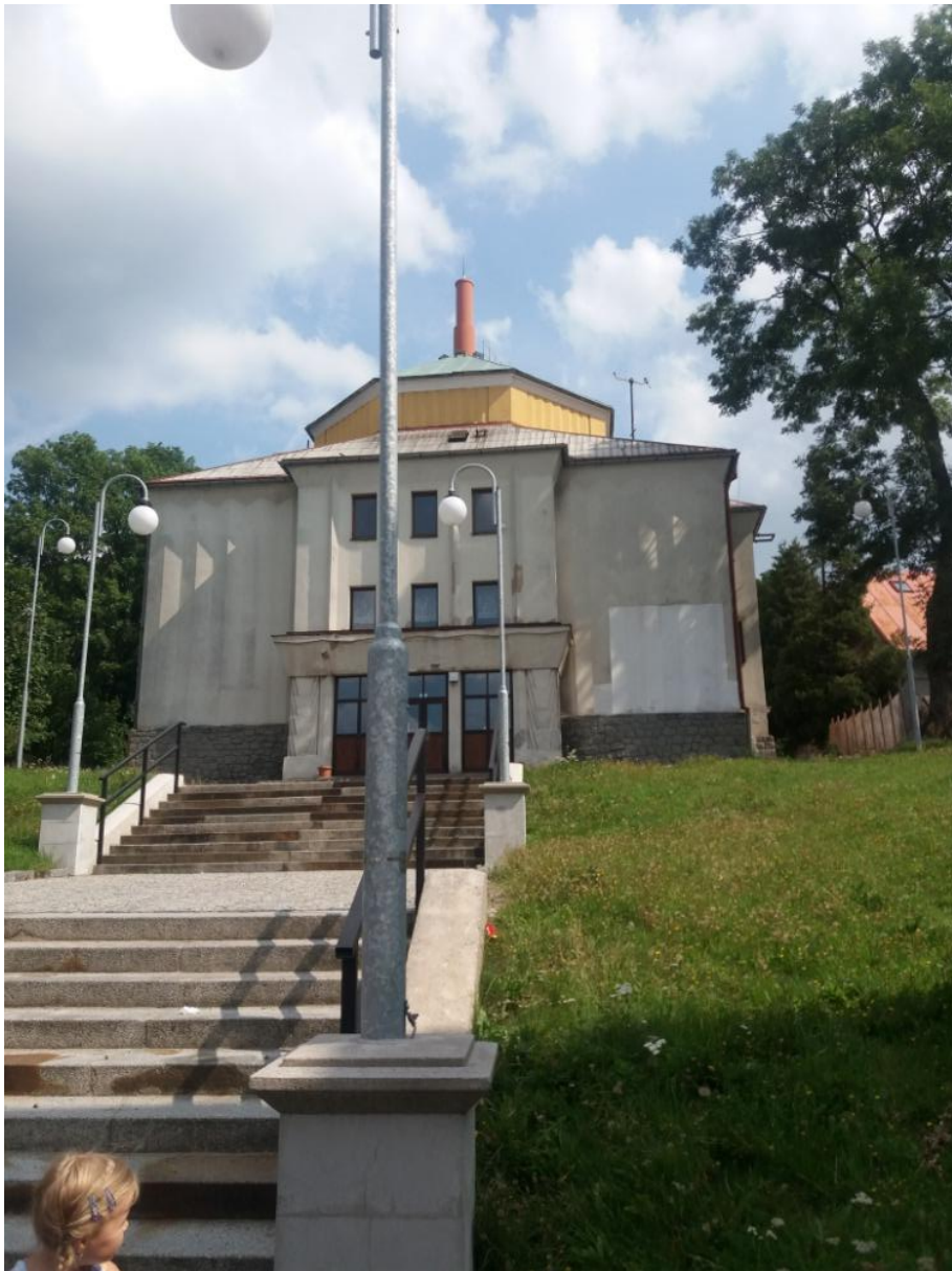
Příloha 1 Budova kina v Kamenickém Šenově
