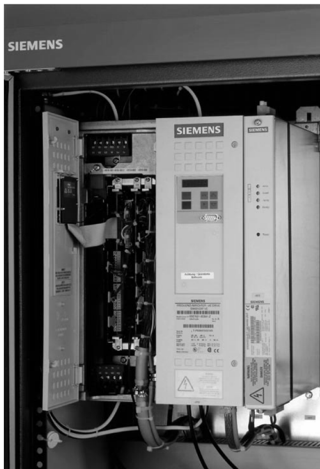
Obr. 4.10: Tranzistorová budící soustava RG3-T4, detail na AVR
