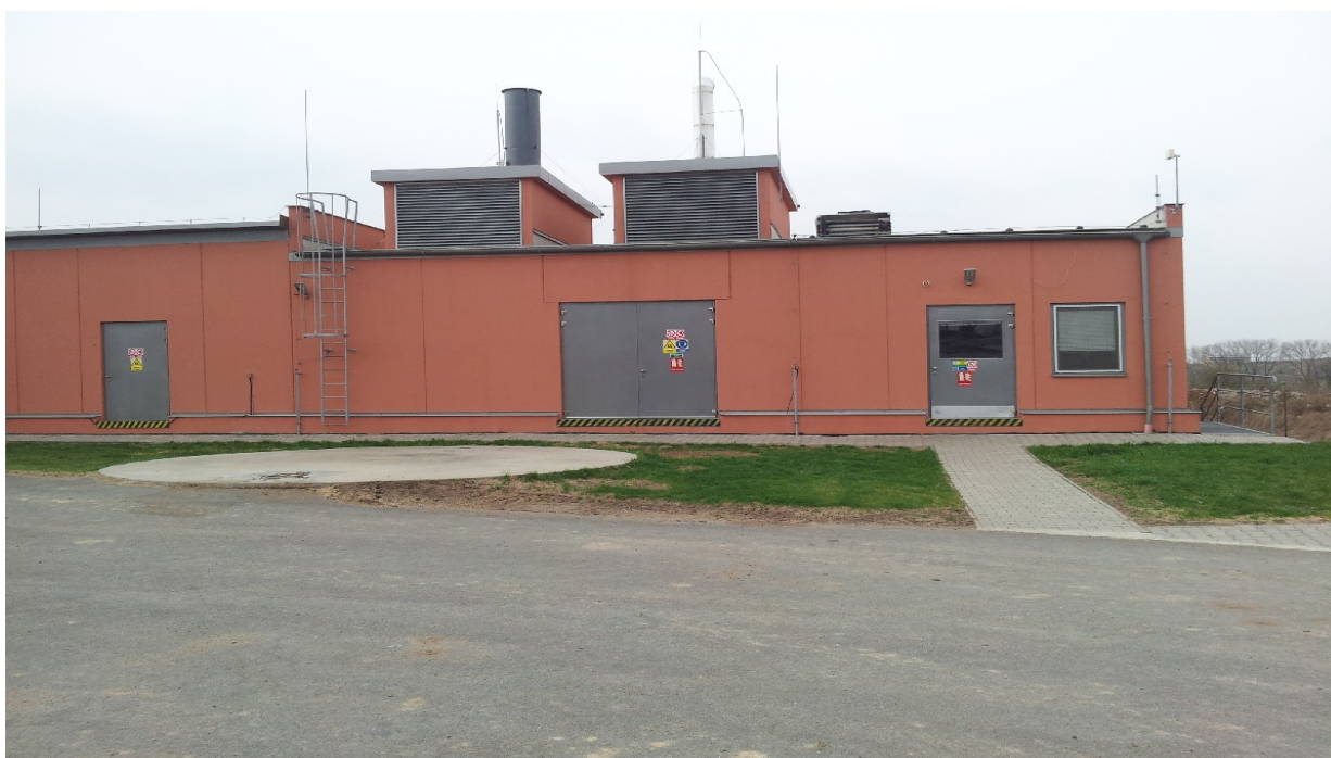
Obr. 18 Bioplynová stanice Mutěnice ( Zdroj: vlastní dokumentace )
