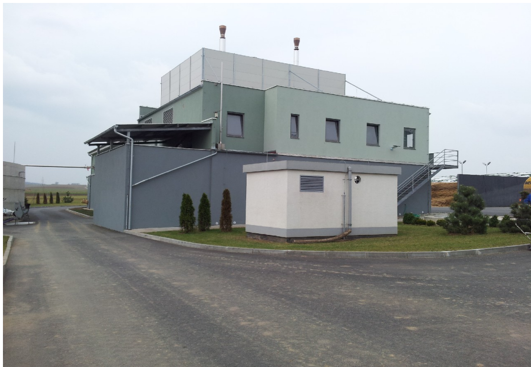
Obr. 21 Bioplynová stanice Švábenice (zdroj: vlastní fotografie)
