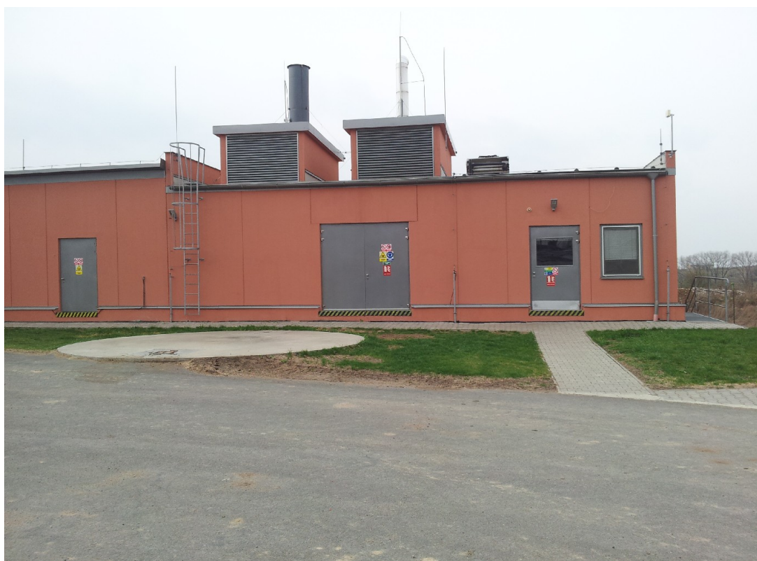
Obr. 22 Bioplynová stanice Mutěnice (zdroj: vlastní fotografie)
