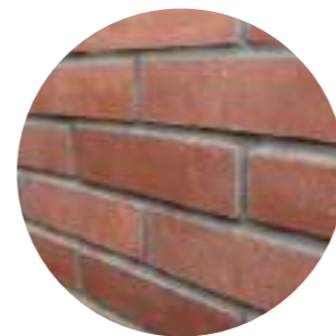
obklad z tehelných páskov fasáda návštevníckeho centra
