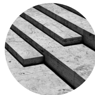
monolitický železobetón vonkajšie pobytové schodisko
