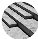
monolitický železobetón vonkajšie pobytové schodisko
