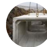
prefabrikované diely rámových nádrží podzemný spojovací tunel
