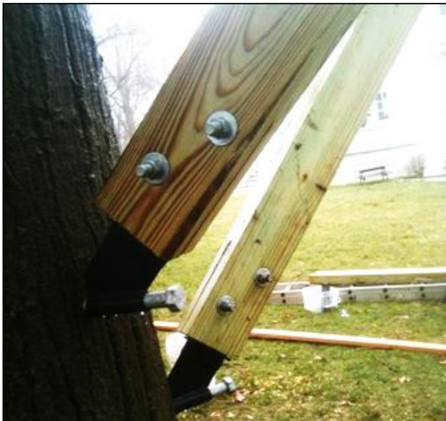
Obr. 12 Využití dalšího typu kovové vložky (Treehouse supplies, 2016)
