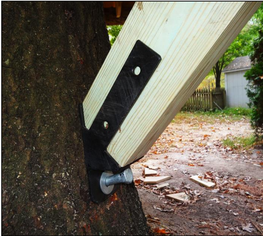
Obr. 11 Uchycení dřevěné vzpěry pomocí kovového segmentu (Treehouse supplies, 2016)
