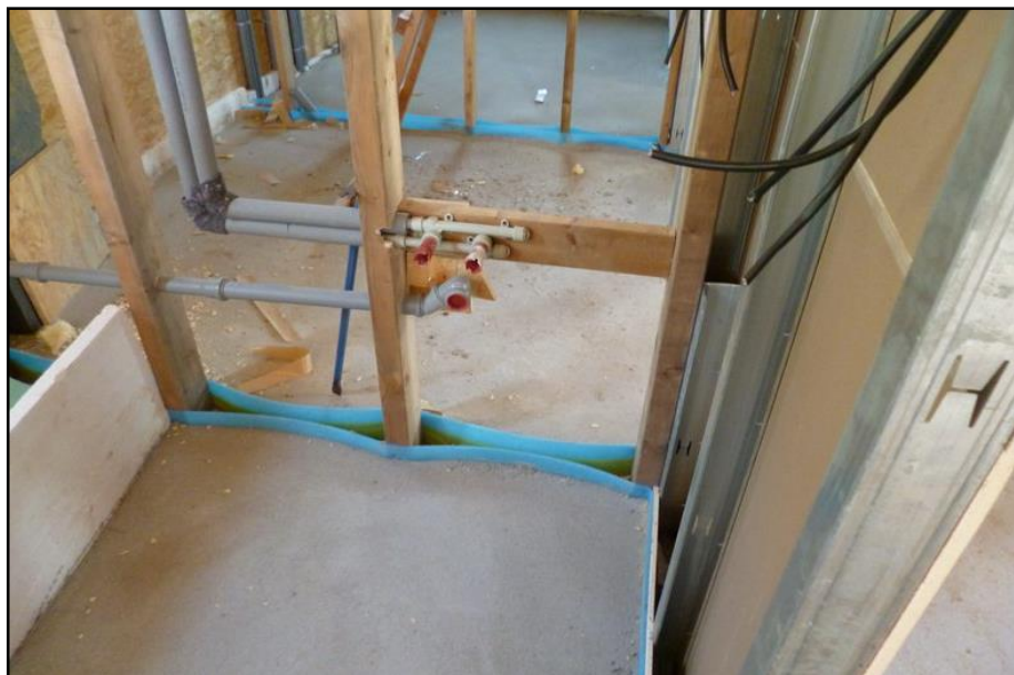
Obr. 40 Ukázka vedení instalačních sítí (Dřevostavby My Home, 2016)
