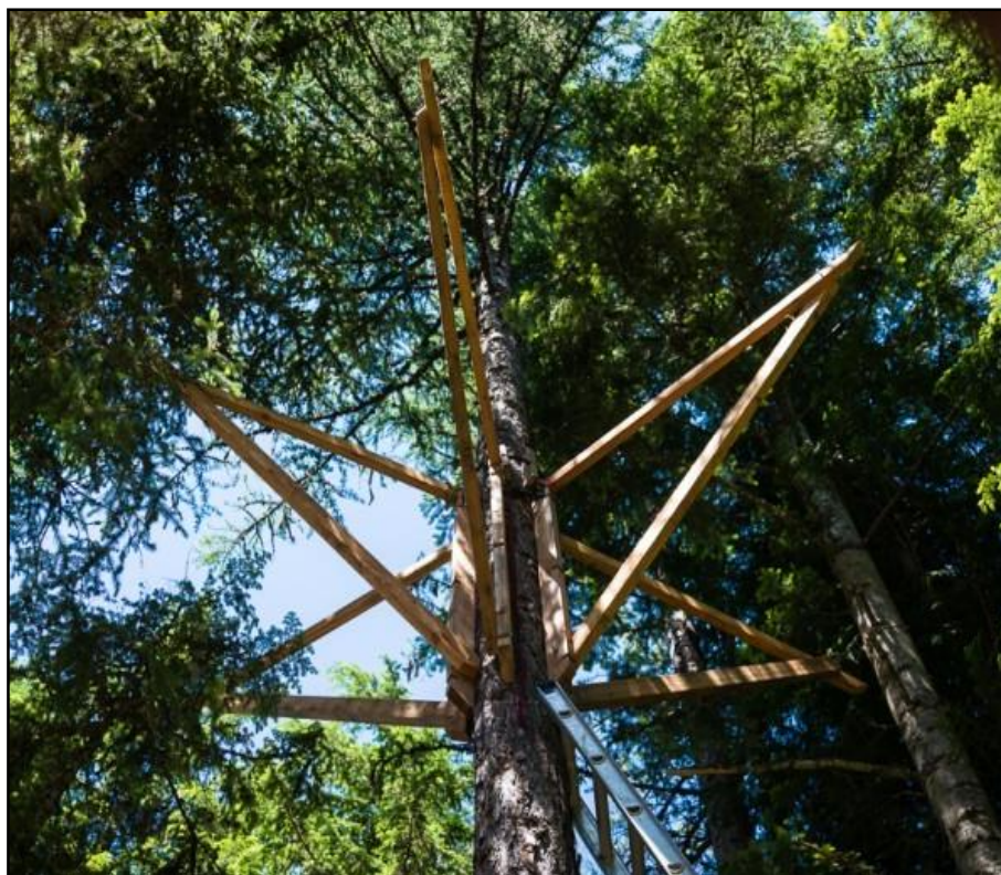
Obr. 8 Náhled na kruhové svorkové základy (Schlussler E., 2016)
