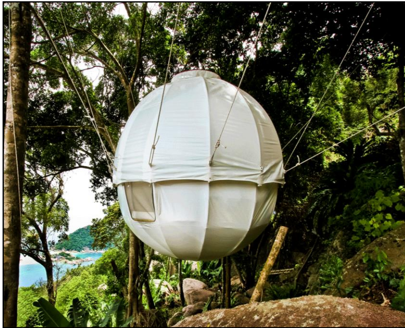
Obr. 6 Založení pomocí ocelových lan (Cocoon tree, 2016)
