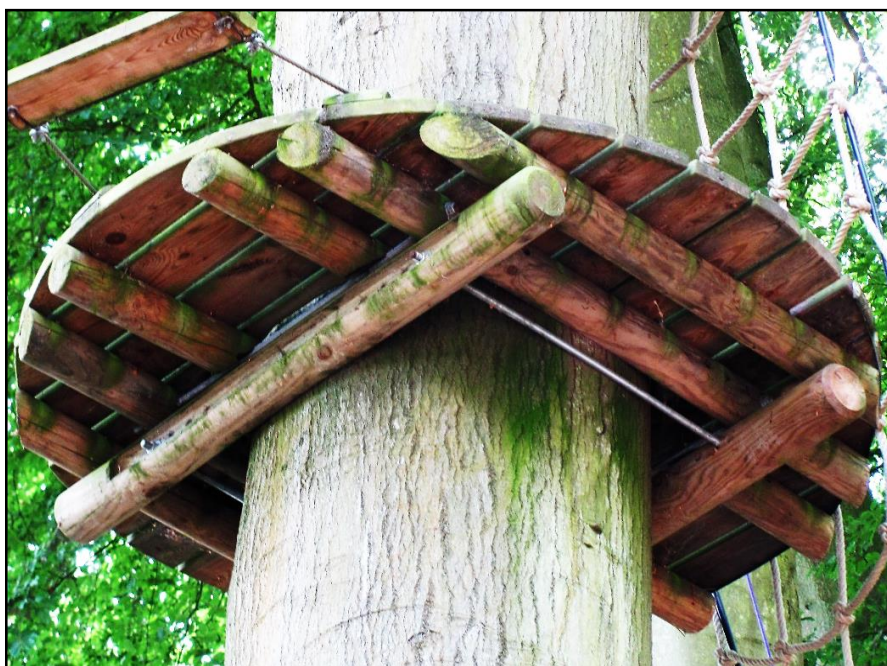
Obr. 7 svorkové patrové založení v praxi (Treehouse supplies, 2016)
