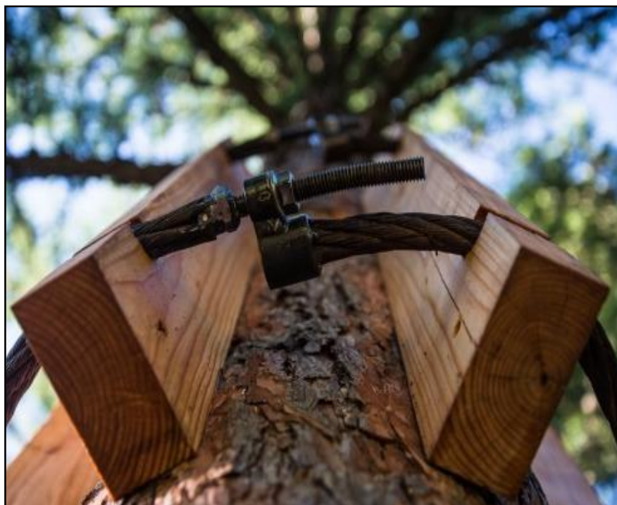
Obr. 9 Detail utahovacího mechanismu u kruhového svorkového založení (Schlussler E., 2016)
