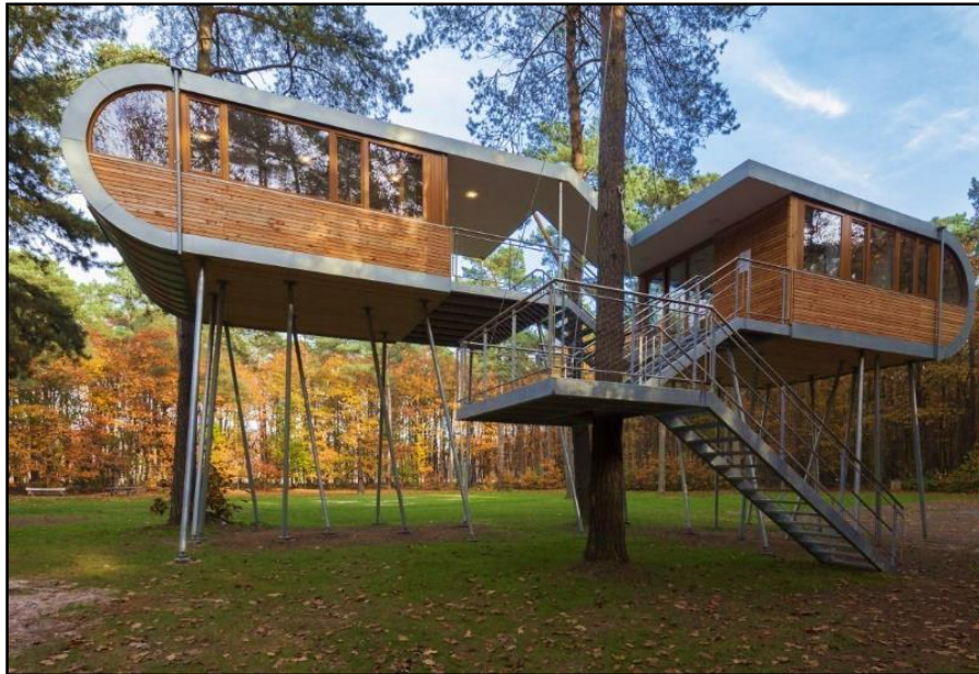
Obr. 5 Ukázka využití ocelových vzpěr (Andreas Wenning, 2014)
