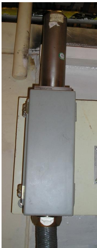
Obr. 13 Ionizační komora RD23
