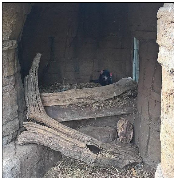
Obrázek 13 - Sklanatá skryš s proskleným průhledem
