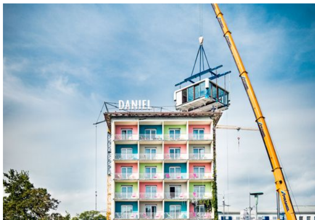
Obr. 30 Instalace Loftcube na střechu Hotelu Daniel; Graz, Rakousko
