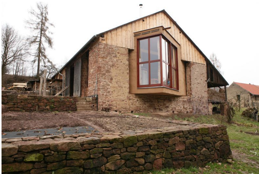
Obr. 38 Pohled na stodolu z jižní strany
