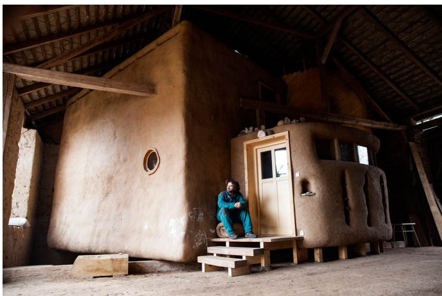
Obr. 43 Slaměný dům ve stodole, nově přibudovaná vstupní část
