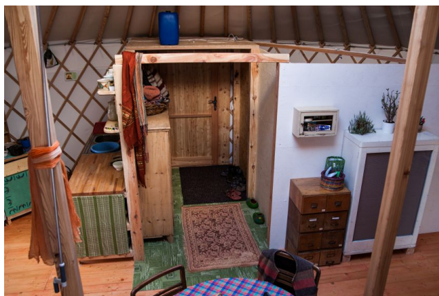
Obr. 35 Interiér je rozdělen SDK příčkami kvůli většímu soukromí
