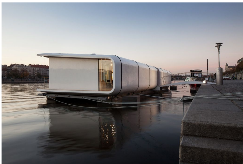
Obr. 14 PORT X vstupní lávka na hausbót
