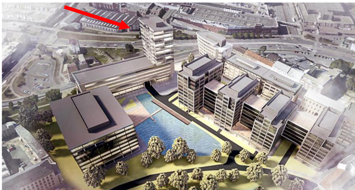
Obrázek 19 Umístění Objektu I v areálu Vlněna (pohled ze severovýchodní strany) [62]
