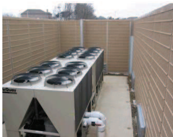
Obr. 25 Chladič chlazený vzduchem se zástěnou [46]
