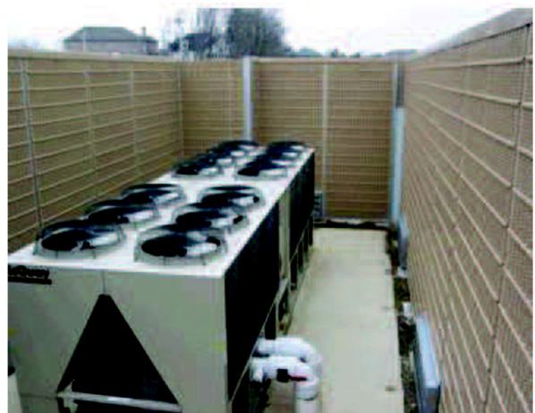
Obr. 25 Chladič chlazený vzduchem se zástěnou [46]
