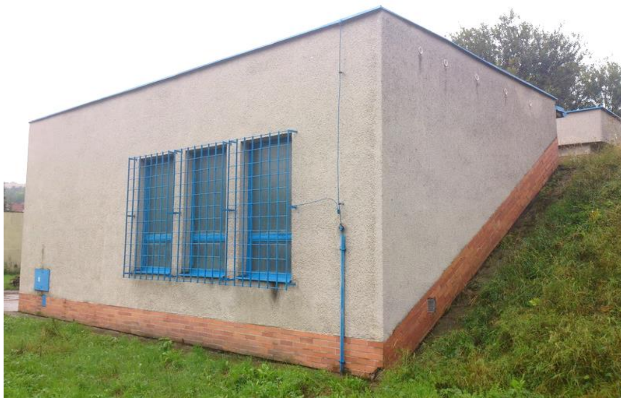
Obrázek 5.1 Pohled na budovu ČS1-BOR
