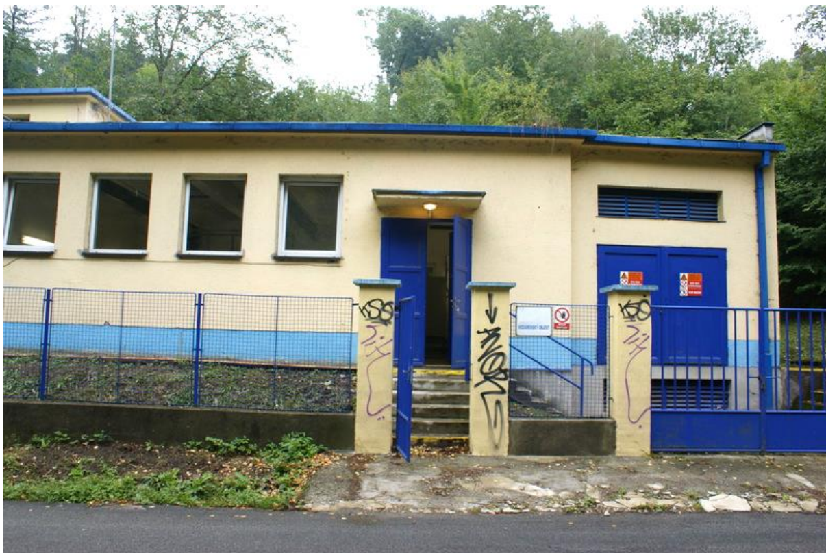
Obrázek 5.4 Pohled na budovu ČS2-HRAD
