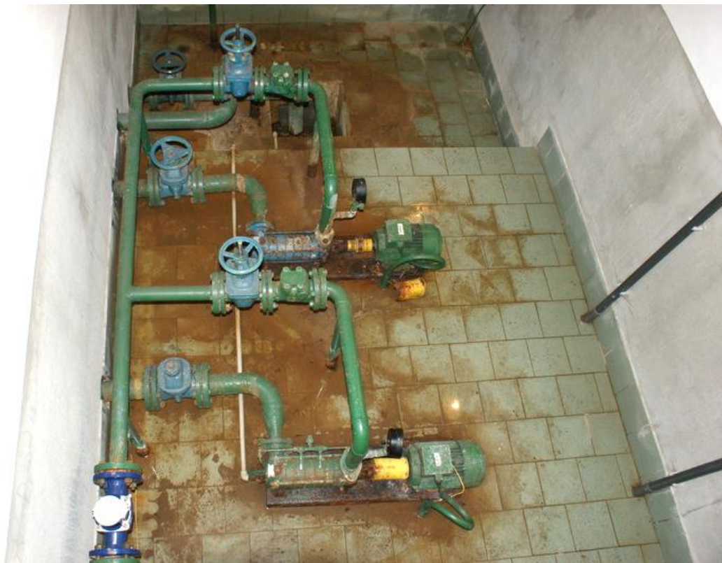
Obrázek 5.8 Technologické vstrojení ČS3-SAL
