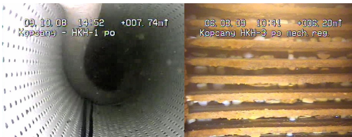
Obrázek 3.3 Snímky výstroje vrtu z kamerového záznamu [18]
