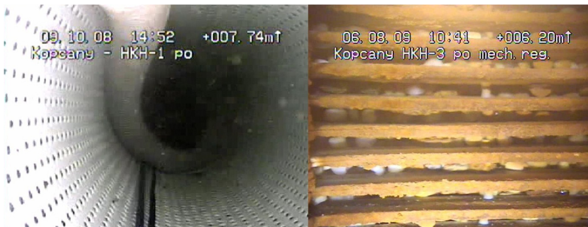
Obrázek 3.3 Snímky výstroje vrtu z kamerového záznamu [18]
