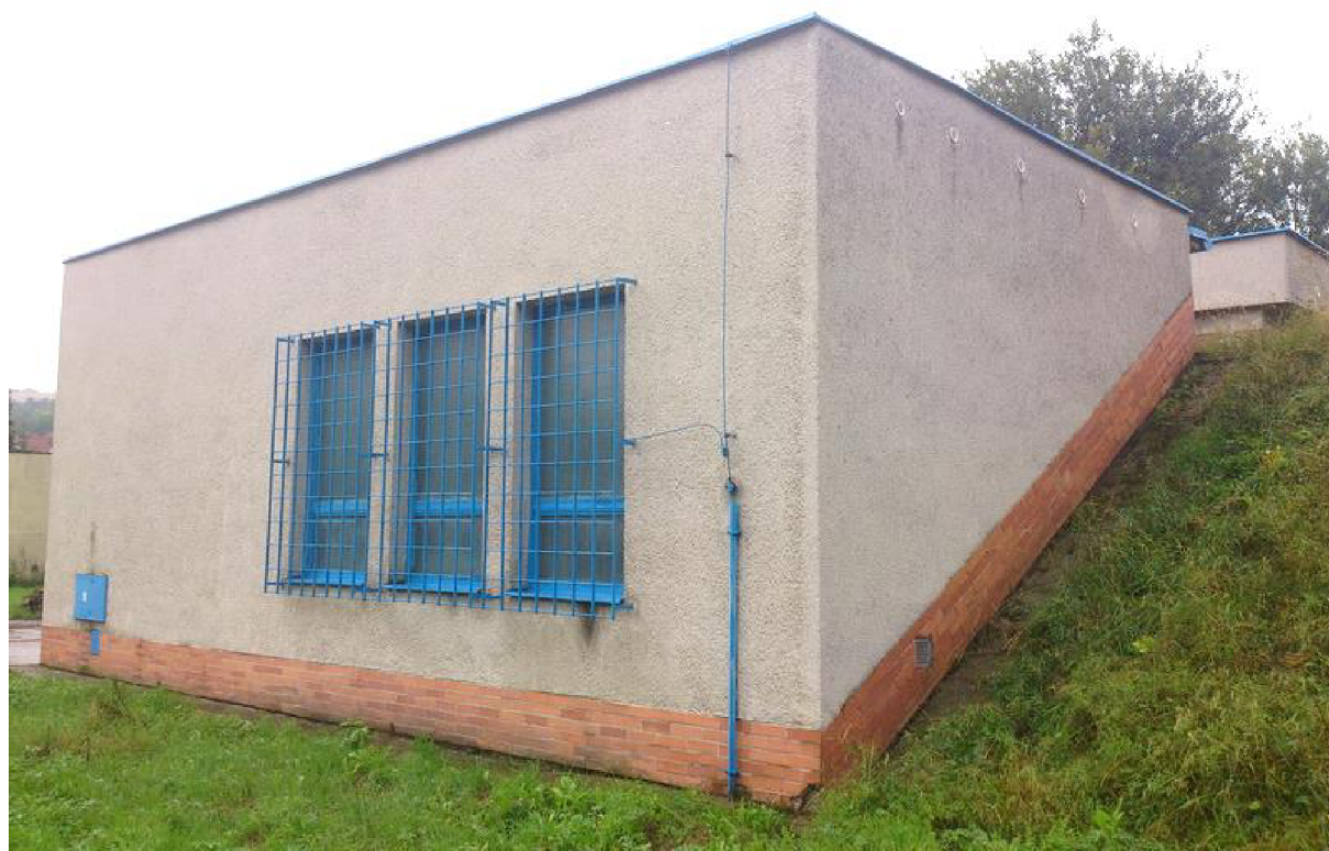
Obrázek 5.1 Pohled na budovu ČS1-BOR
