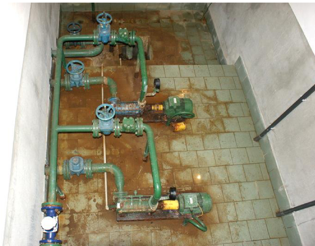
Obrázek 5.8 Technologické vstrojení ČS3-SAL
