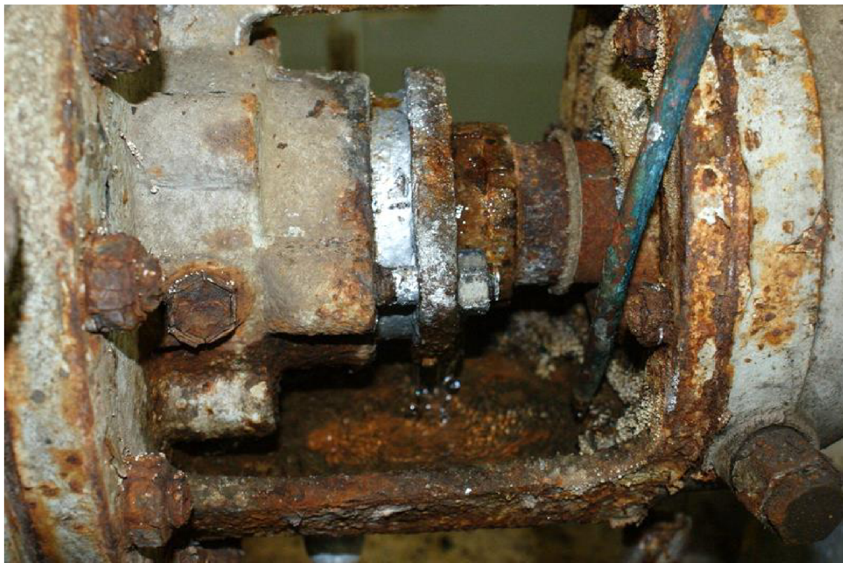
Obrázek 5.6 Detail spoje motor-čerpadlo na čerpací stanici ČS2-HRAD
