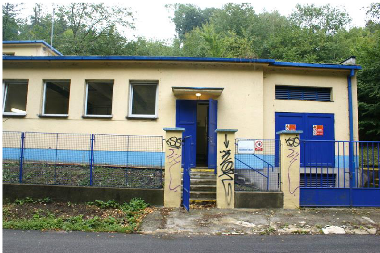
Obrázek 5.4 Pohled na budovu ČS2-HRAD
