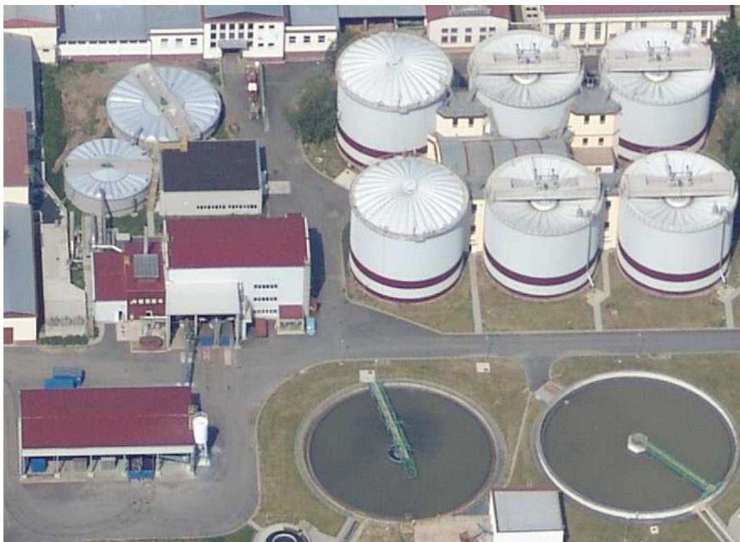
Obr. 4 Anaerobní stabilizační reaktory ČOV Modřice [3]
