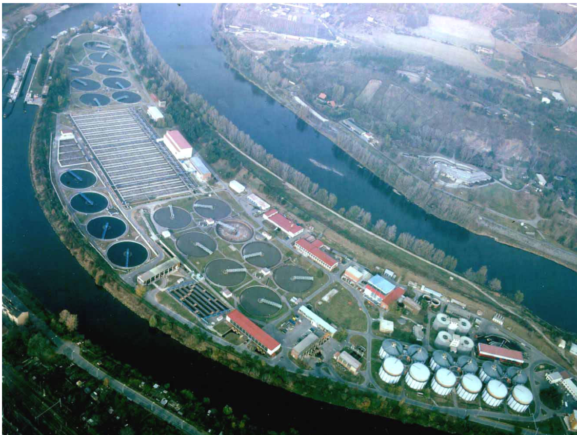
Obr. 2 Letecký snímek ÚČOV Praha [8]
