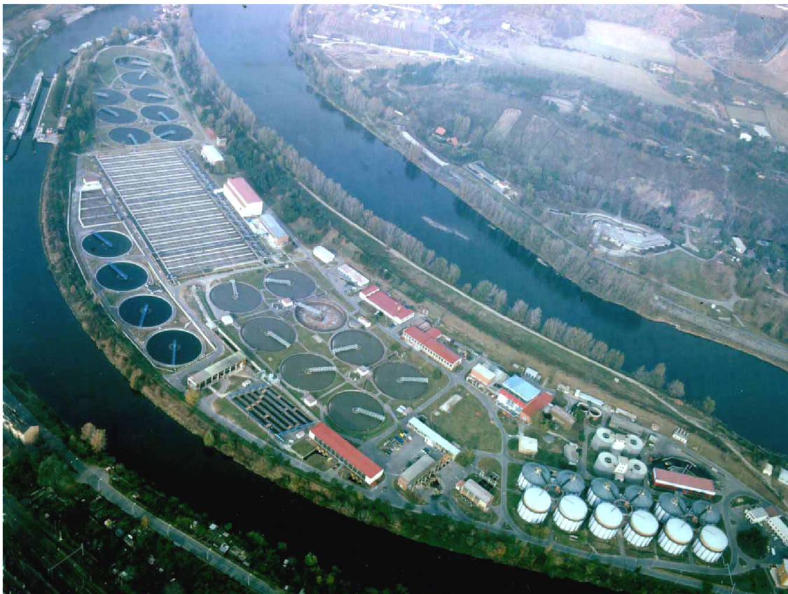
Obr. 2 Letecký snímek ÚČOV Praha [8]
