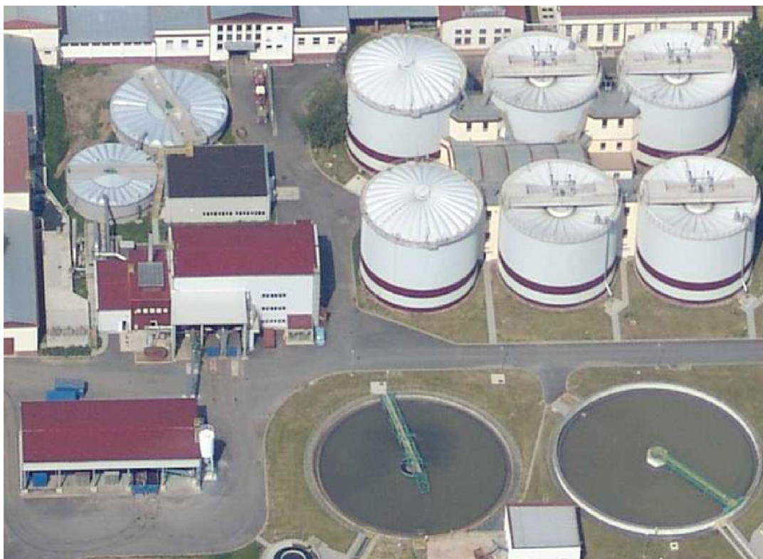
Obr. 4 Anaerobní stabilizační reaktory ČOV Modřice [3]
