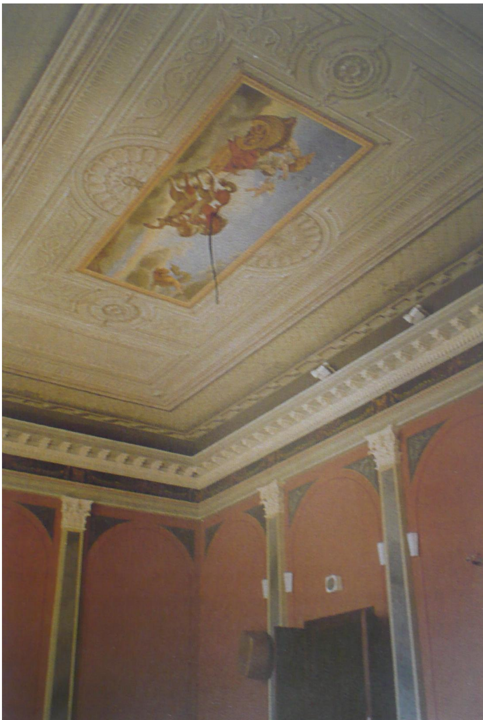
Obrázek 67: Nástěnné malby auly, 1875-1877, Justiční akademie, Kroměříž. Stav po rekonstrukci. Foto:NPÚ ÚOP Kroměříž.
