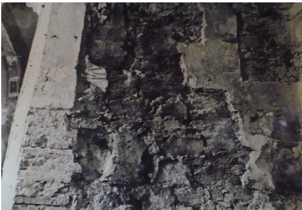
Obrázek 47: Vyšehoří, kostel Všechn svatých, 14.století. Sondy v omítkách, renesanční vyzdívka vítězného oblouku, fragmenty nejstarších vrstev s malbami. Foto: NPÚ ÚOP Olomouc.
