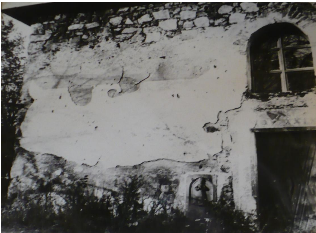
Obrázek 46: Vyšehoří, kostel Všechn svatých, 14.století. Průčelí věže s fragmenty malby na barokní omítce. Foto: NPÚ ÚOP Olomouc.
