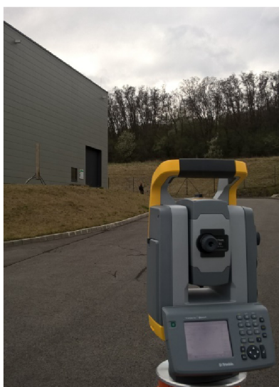
Obr. 15 Zaměrování kontrolních profilů
