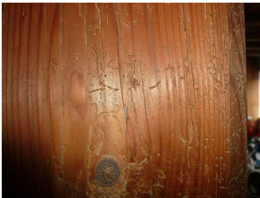
Obrázek 24: Napadení červotočem u sloupu č. 2
