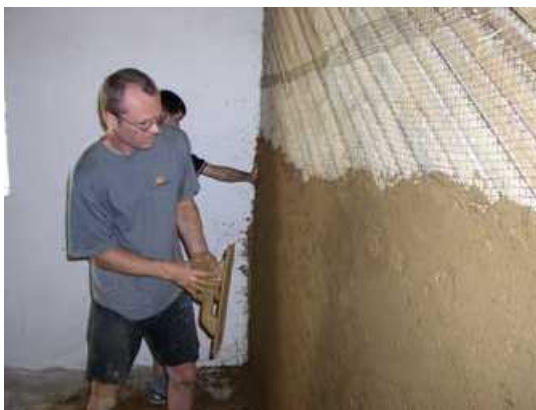
Obrázek 5: Provádění hliněných omítek rok 2004 ( http://www.hornimlyn.cz/ )
