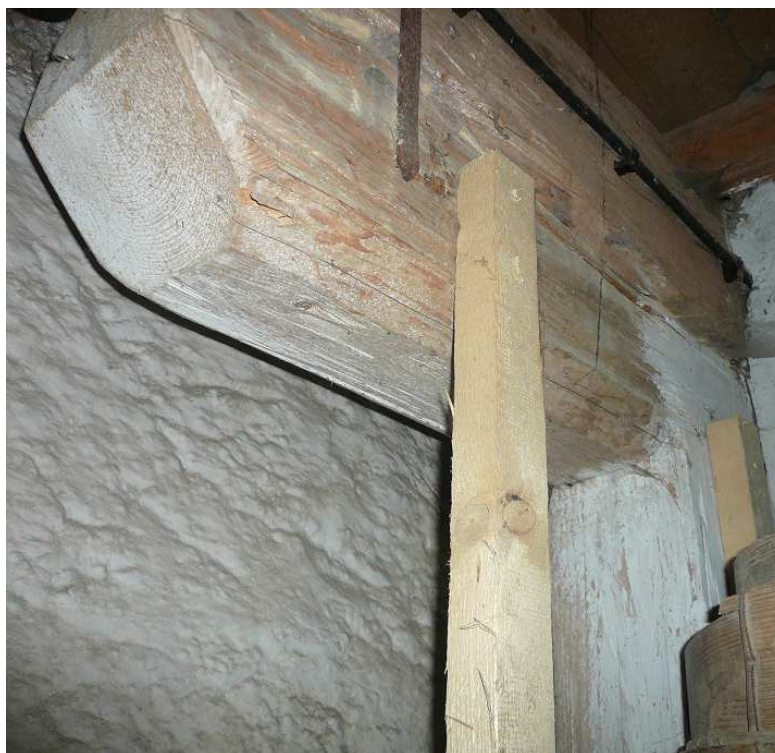
Obrázek 21: Průvlaky v prvním nadzemním podlaží
