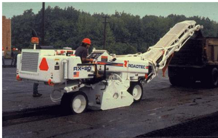
Obr. 3.7 Metoda frézování [12]
