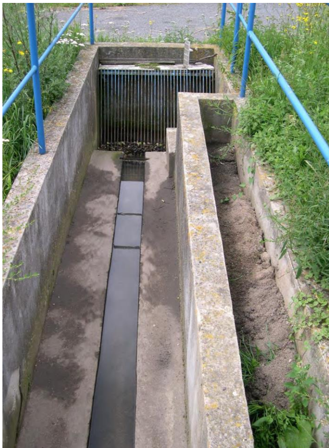
Obr. 3.7 – Horizontální lapák písku žlabový (prezentace Vymazal J.)
